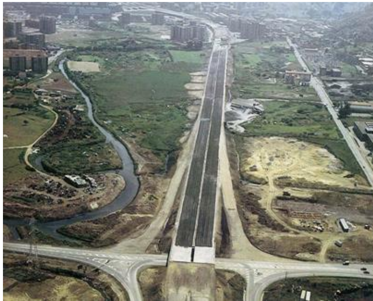
15. Irudia: A8 autopistaren eraikitzea Barakaldon, 1986. Iturria: Barakaldoko Udala.
