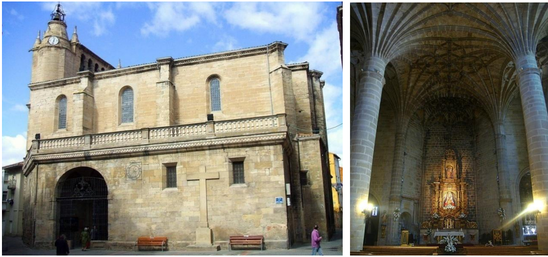
Fig. 4. Exterior y nave de la iglesia de Santa María de Altamira. Miranda de Ebro.
