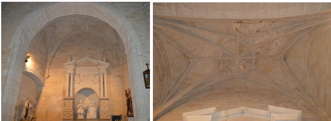
Fig. 5. Arco de ingreso y bóveda de crucería. Juan Alonso de Rivas. Capilla de los Barrón. Iglesia de Santa María de Altamira.
