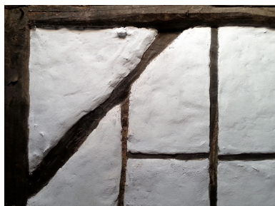
51. Irudia. Zurezko bilbaduraren xehetasuna, barne-banaketako mehelin horma. Barrutieta baserria. Iturria: egilea.
