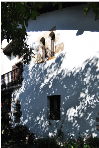
59. Irudia. Leiho bikia. Gerrikagoitia baserria. Iturria: egilea. Figura 59. Ventana geminada. Caserío Gerrikagoitia. Fuente: propia.
