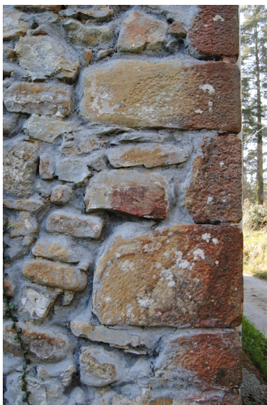
11. Irudia. Barrutieta baserriaren atzeko fatxadaren harladuen egoeraren detailea. Iturria: egilea, 2016.
