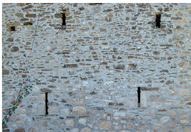
62. Irudia. Atzeko fatxadako gezileihoak. Ormaetxea baserria. Iturria: egilea. Figura 62. Aspilleras de fachada trasera. Caserío Ormaetxea. Fuente: propia.
