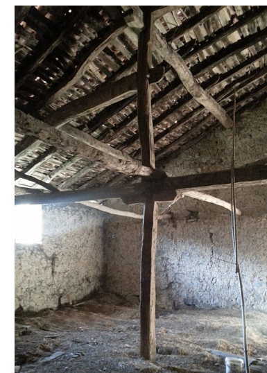
55. Irudia. Zutikoen gainezarpene. Itza baserria. Figura 55. Superposición de pies derechos. Caserío Itza. Fuente: propia.
