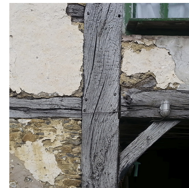
Figura 4. Unión caja-espiga. Fuente propia.
