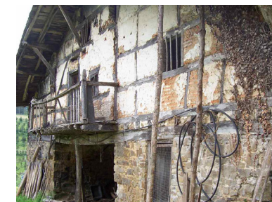
52. Irudia. Zurezko bilbadura eta betegarri zeramikoaren xehetasuna. Astorki-bekoa baserria. Iturria: Bizkaiko Katastroa [54].
