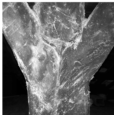
19. Irudia. Zurruntze besoen eta zutabearen arteko lotunearen xehetasuna. Iturria: egilea.
