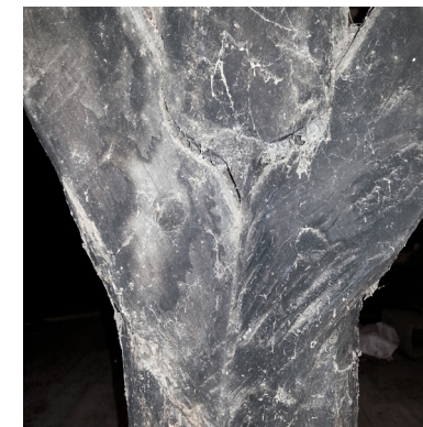
56. Irudia. «Enara-hego» lotura. Otatzandiaga baserria. Iturria: egilea. Figura 56. Unión «ala de golondrina». Caserío Otatzandiaga. Fuente: propia.
