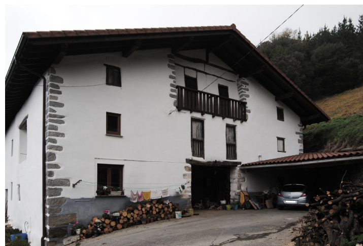
Figura 28. Estado del caserío Lexarra bekoa. Años 1990 (A. Zubikarai) y 2016 (fuente propia).
