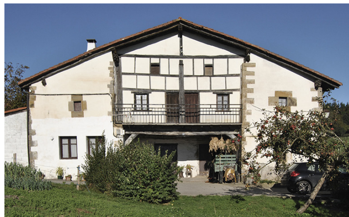
Figura 6. Estado del caserío Gerrikabeitia. Años 1992 (A. Zubikarai) y 2016 (fuente propia).
