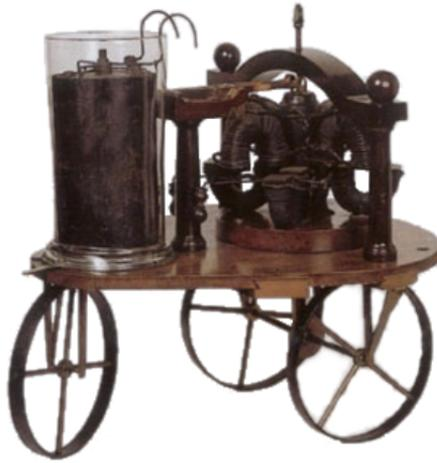
Figura 2.3: El “Electromagnetic car” de Stratingh y Becker [? ?].
