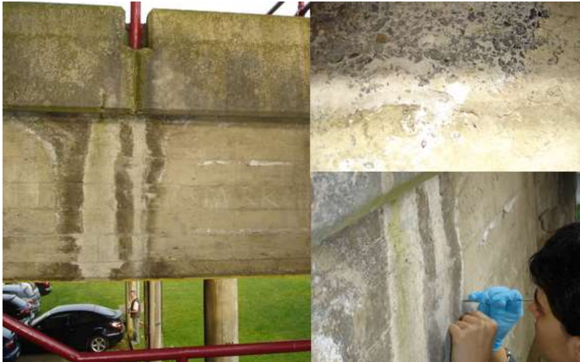
Figura 4.5: estructuras de hormigón armado analizadas in situ en Leioa.
