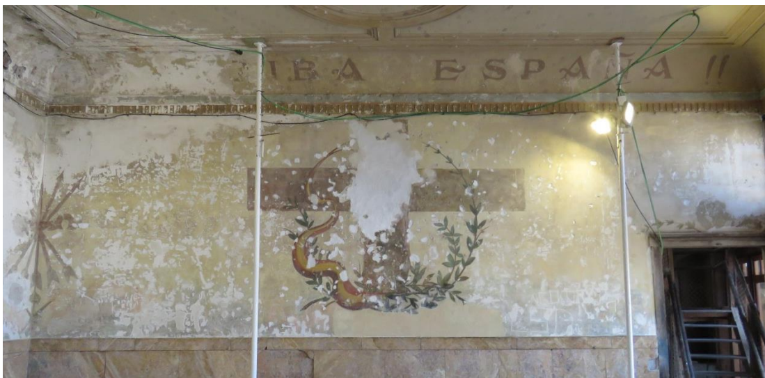
Figura 7.32. Aspecto final de la restauración de lagunas.
