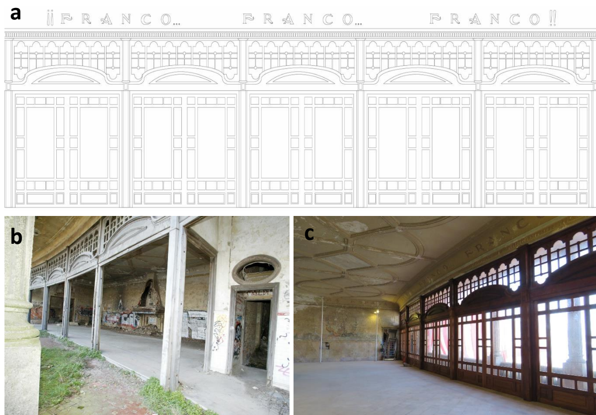
Figura 4.21. a) Dibujo del cerramiento del salón, junto con los lemas de la cornisa, b) Imagen del 2007 en el que se aprecia el descarne de las maderas y c) Imagen en la actualidad tras la restauración hecha.
