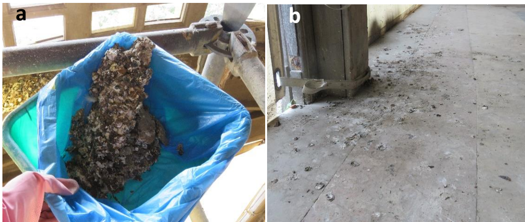
Figura 7.3.a) Costra eliminada mediante espátula y, b) Depósitos restantes tras esta eliminación.
