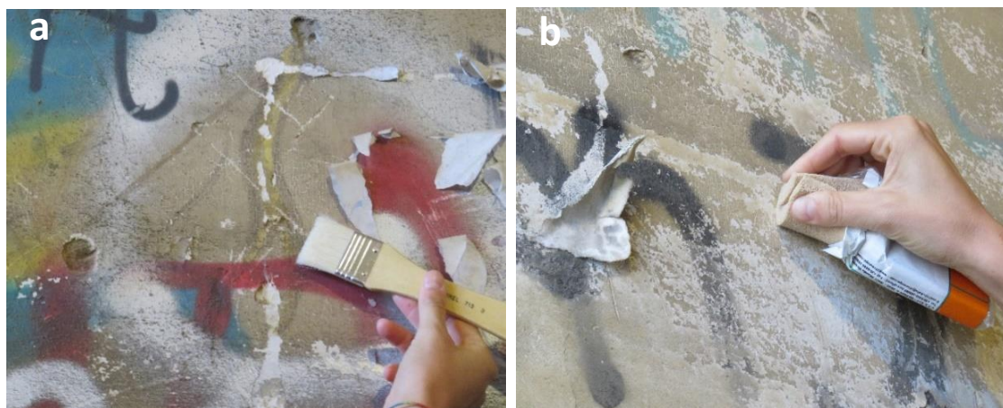
Figura 7.18. a) Eliminación de la suciedad mediante brocha, y b) Prueba con goma vulcanizada.
