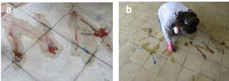
Figura 7.2.a) Aplicación del decapante y b) Proceso de eliminación con lanas de acero nº00 de las tintas de grafiti ubicadas en el suelo.
