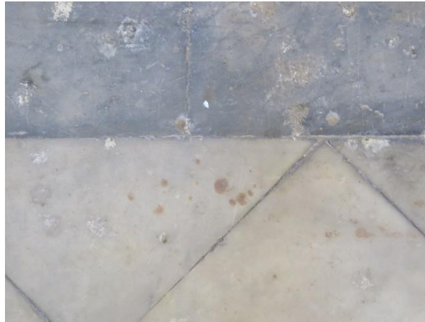
Figura 3.17. Pequeñas manchas redondas de color anaranjado, presumiblemente impurezas generadas por las partículas metálicas del mármol blanco de Carrara.
