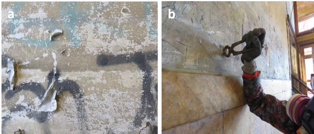
Figura 7.26. a) Papeles adheridos y b) operación de extracción de clavos.
