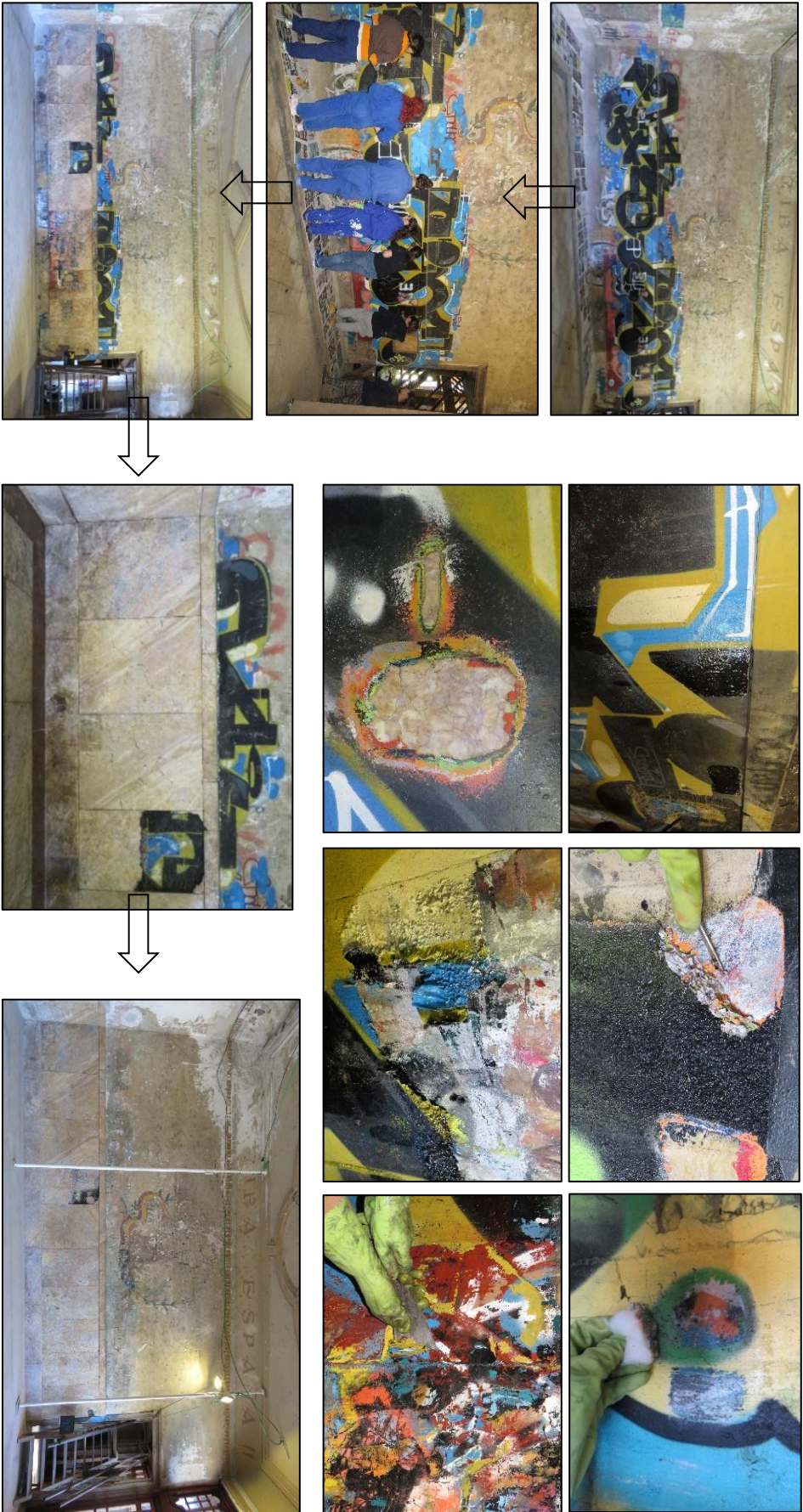
Figura 7.10. Proceso de eliminación de grafitis y pátinas en la pared 4.
