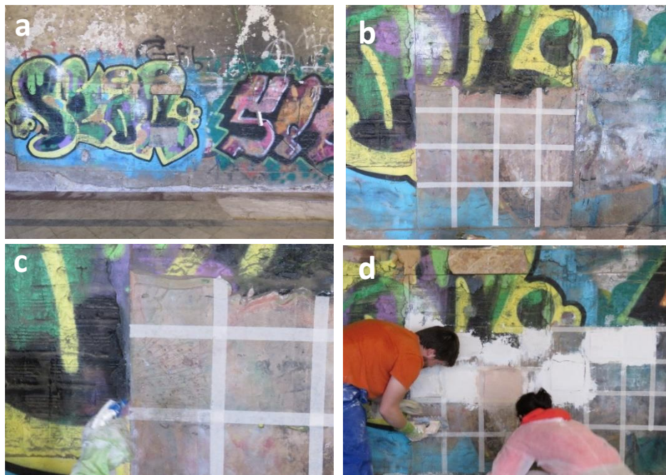
Figura 7.13. a) Pared 2 antes de la intervención, b) Eliminación de grafitis y cuadrículado de la zona, c) Picado de la pared y, d) Aplicación de los morteros de prueba.
