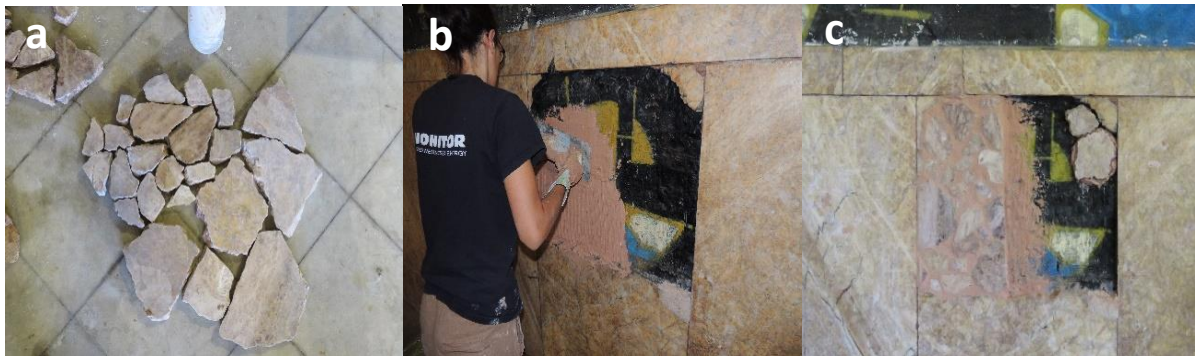
Figura 7.15. a) Fragmentos seleccionados de mármol de distintas medidas para la elaboración del puzle, b) Momento de aplicación del mármol coloreado para el agarre de las piezas y c) Inclusión de las piezas y resultado final de la prueba.
