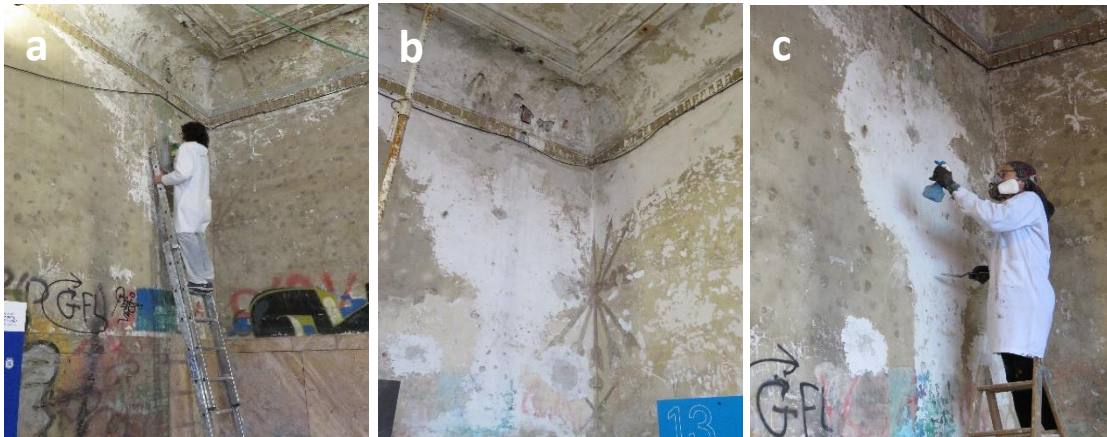
Figura 7.24. a) Intervención con fungicida en spray, b) Esquina tras las aplicaciones del fungicida y c) Pulverización de alcohol para mantener controlado el ataque microbiológico.
