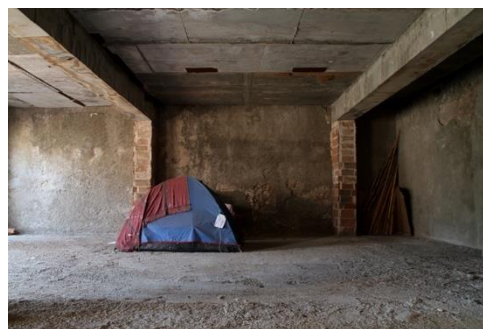
Imagen 13. Tiendas provisionales Casa Roja. Fuente: Calafou, 2011.
