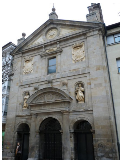
Figura 16. Vitoria. Convento de la Purísima Concepción o de San Antonio. Iglesia. Fachada
