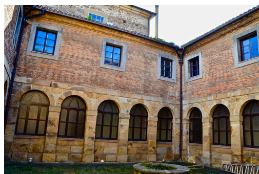
Figura 140. Lazcano. Convento de Santa Teresa. Patio
