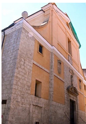
Figura 118. Valladolid. Parroquia de San Miguel y San Julián, antiguo colegio de San Ignacio. Fachada
