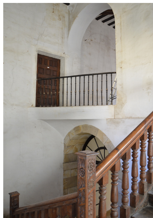
Figura 63. Lazcano. Palacio de Lazcano. Balcón sobre la escalera
