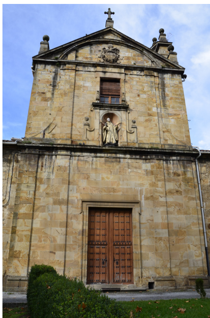
Figura 167. Lazcano. Convento de Santa Ana. Iglesia. Fachada
