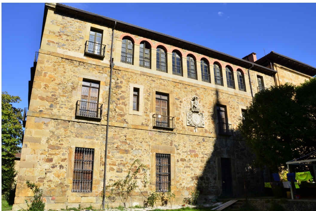
Figura 42. Lazcano. Palacio de Lazcano. Fachada oriental
