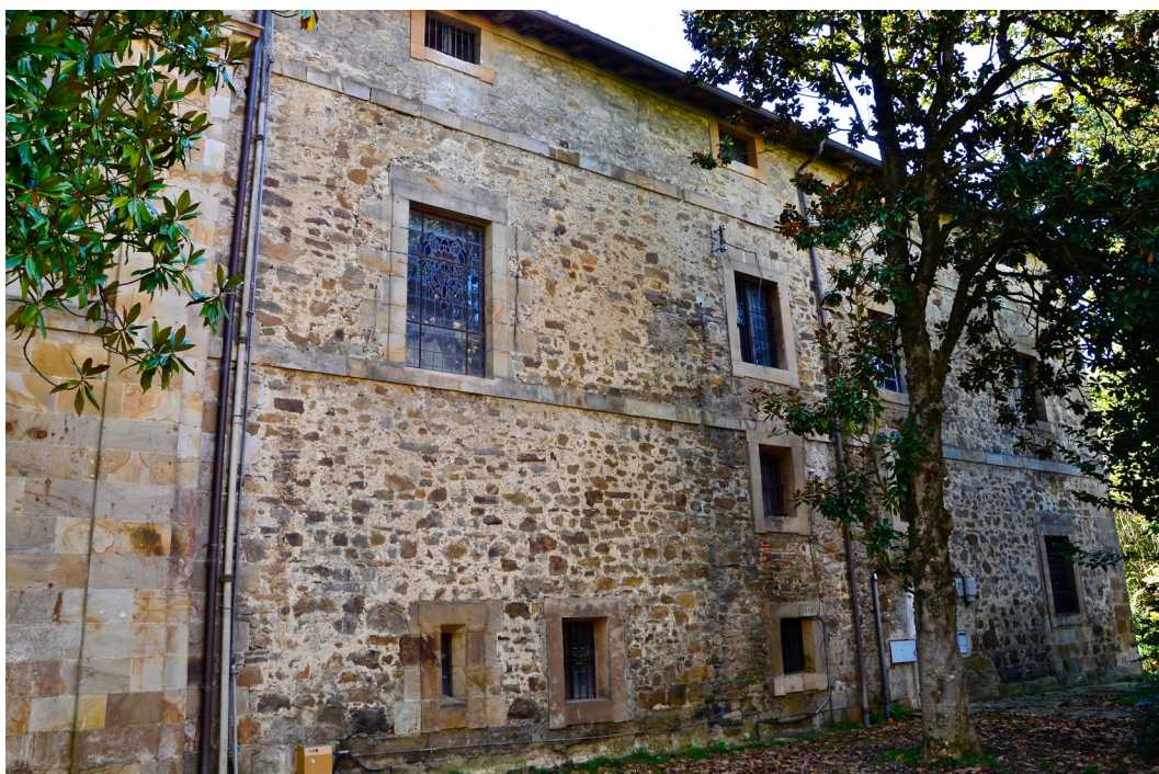
Figura 43. Lazcano. Palacio de Lazcano. Fachada occidental
