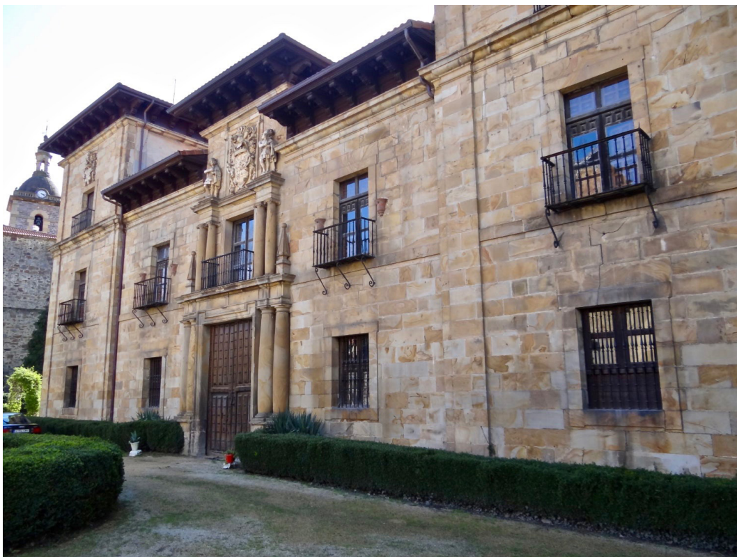
Figura 39. Lazcano. Palacio de Lazcano. Fachada principal
