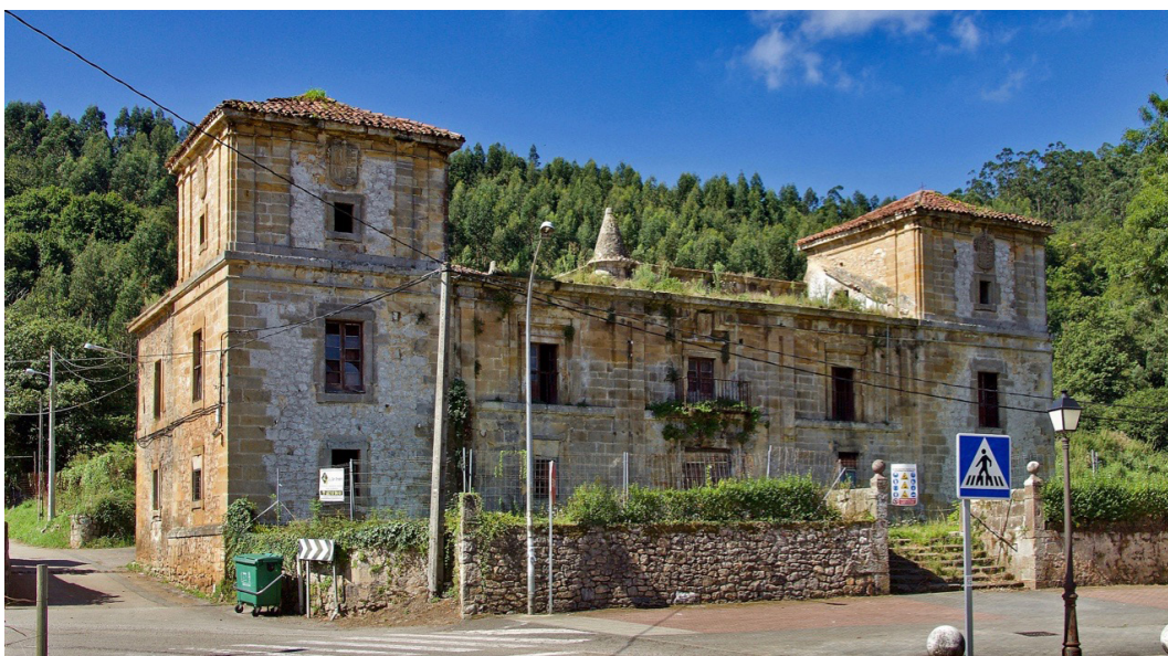
Figura 69. Hoznayo. Palacio de los Acebedo. Fachada
