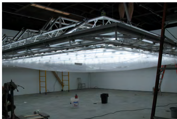
Proceso de montaje de ANTONY GORMLEY. Blind light . 2007
