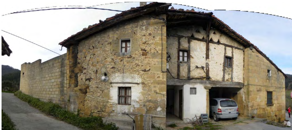
Figura51: Imagen del caserío Besoitaormaetxea antes de los trabajos de rehabilitación. Foto: Atelier Arquitectos.
