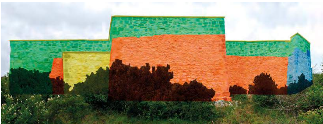
Figura 4.22. Treviño. Fases constructivas diferenciadas en la lectura estratigráfica, desarrollada en 2008, de la antigua parroquia de Santa María. En rojo se marca la fase 2 (finales siglo XII-mediados siglo XIII), en azul la fase 3 (finales siglo XIV-primer mitad siglo XVI), en verde la fase 4a (siglos XIX), en amarillo la fase 4b (siglo XX).
