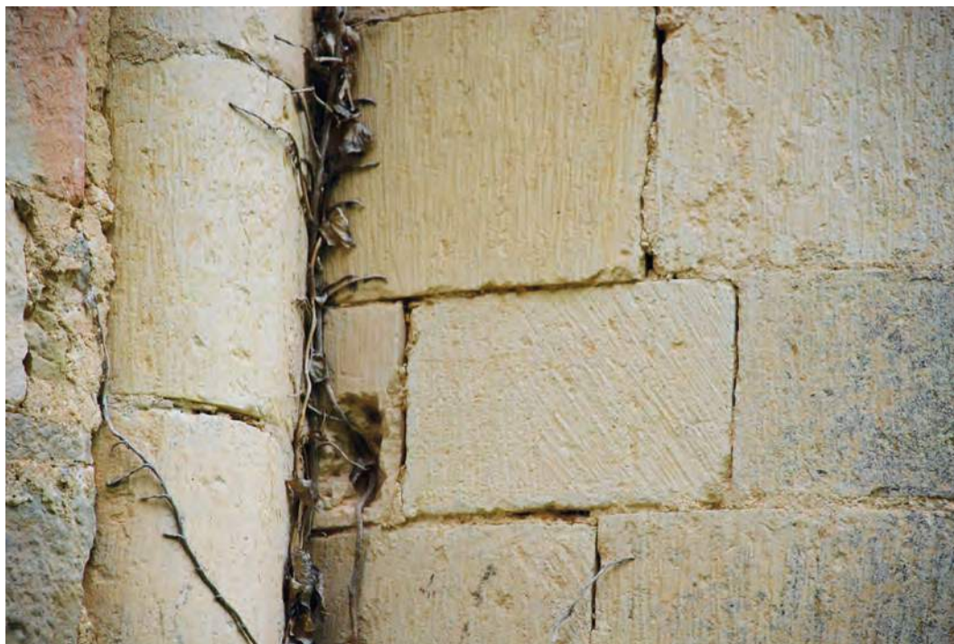
Figura 4.32. Treviño. Fotografía del sillar tallado con tallante y gradina en el torreón N de la ermita de San Juan Bautista.
