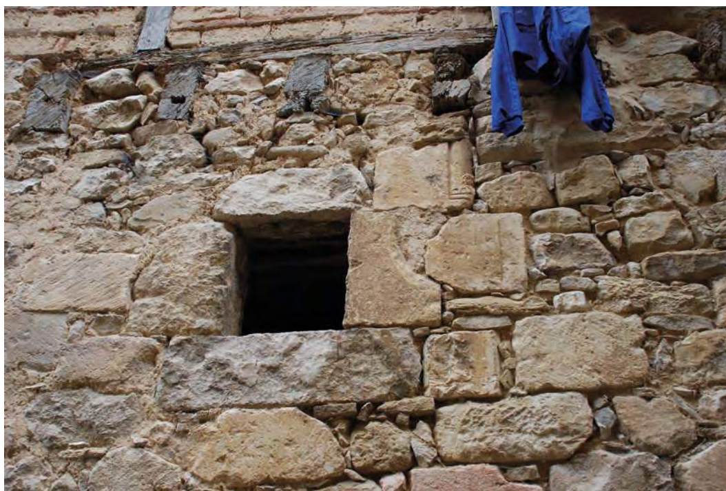
Figura 4.33. Treviño. Fotografía de elementos reutilizados de la fase 1 de la ermita de San Juan Bautista como aparejo en una casa de la villa.
