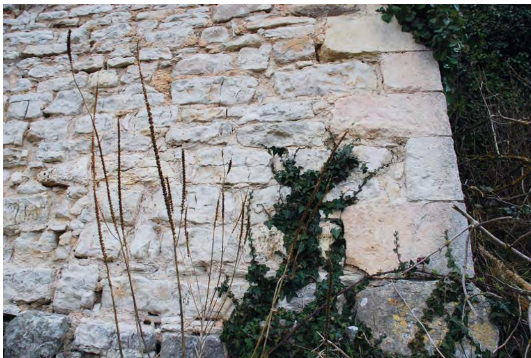
Figura 4.25. Treviño. Fotografía del aparejo (a base de mampuestos en los muros y sillarejo en los esquinales) de la fase 2 de la antigua parroquia de Santa María.
