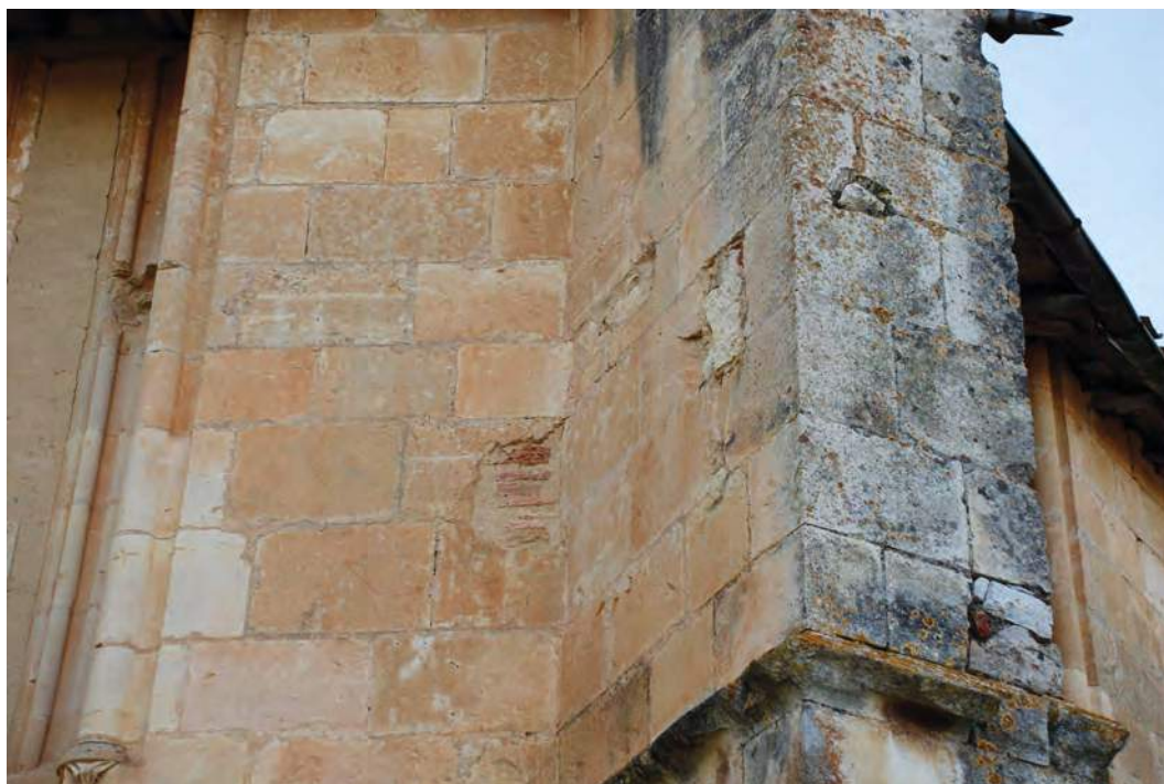
Figura 4.30. Treviño. Fotografía del aparejo de sillería de la fase 1 de la ermita de San Juan Bautista.
