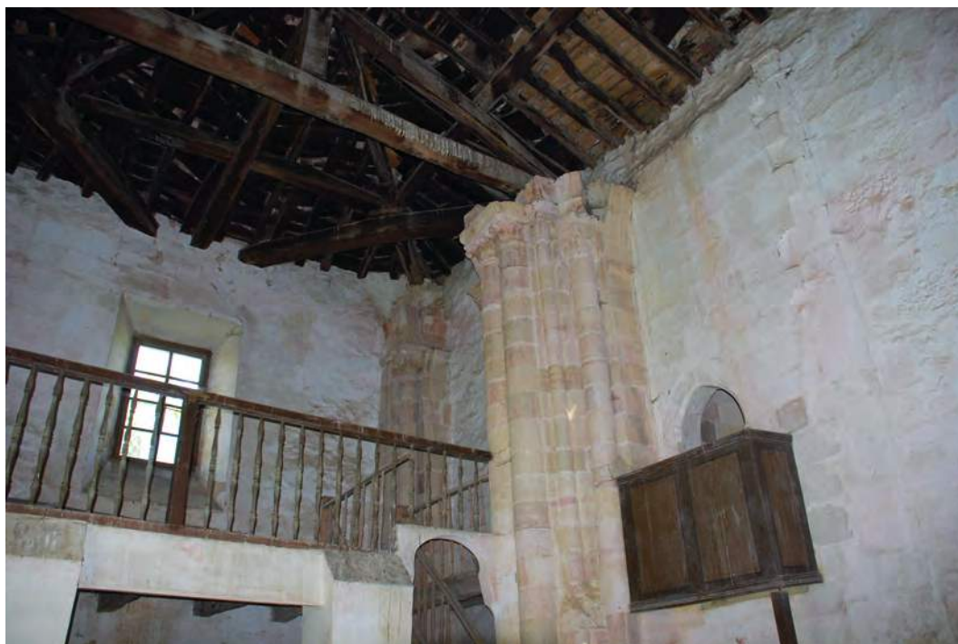
Figura 4.31. Treviño. Fotografía de los apoyos interiores de la fase 1 conservados en la esquina NW de la ermita de San Juan Bautista.
