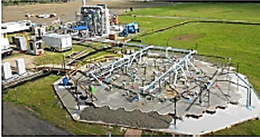
Figura 1.9. Instalaciones para tratamiento térmico empleando la metodología de calentamiento mediante resistencia eléctrica (ERH) [30].
