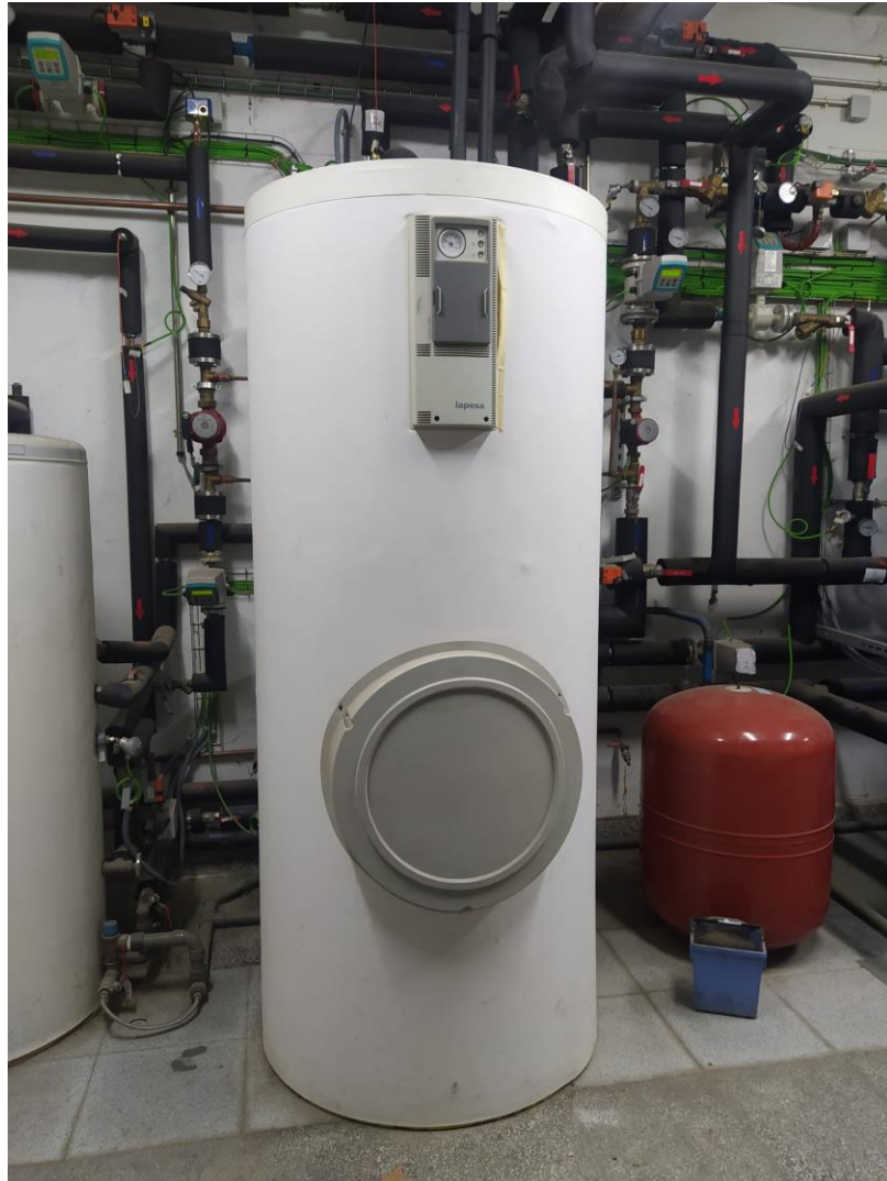
Imagen 30. Depósito de acumulación
