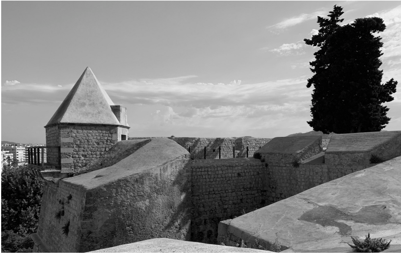
Baluarte de Sant Joan /Fot. propia
