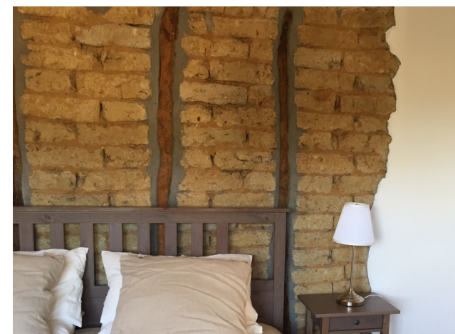
El adobe es celebrado en la familia Peña, donde los descendientes de Justi „El Caminero” visibilizan la estructura de tierra. (Imagen: Alicia Ruiz Caballero)
