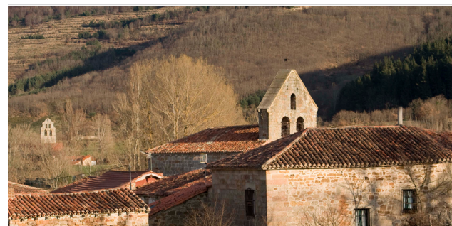
Vista de San Martín de Valdelomar, con Sta. Ma. de Valverde al fondo. (Fuente: web municipal)
