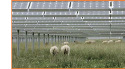
Granja solar de generación
