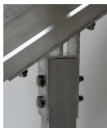
Detalle unión pata-viga
