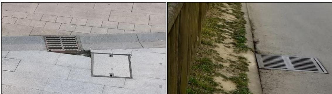
*Ilustración 4. Imbornales de recogida de pluviales. Fuente: Autor*
