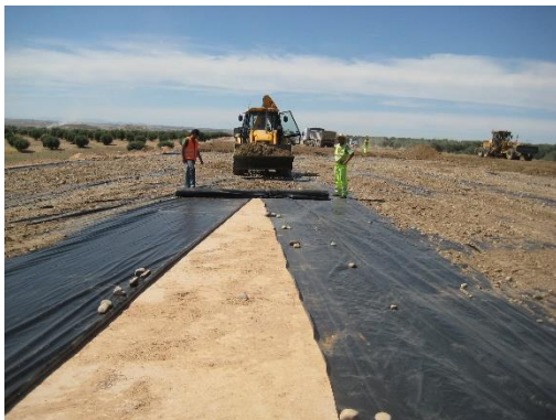
55. Irudia. Geotextilaren kokapena. Iturria: geotexan.com
