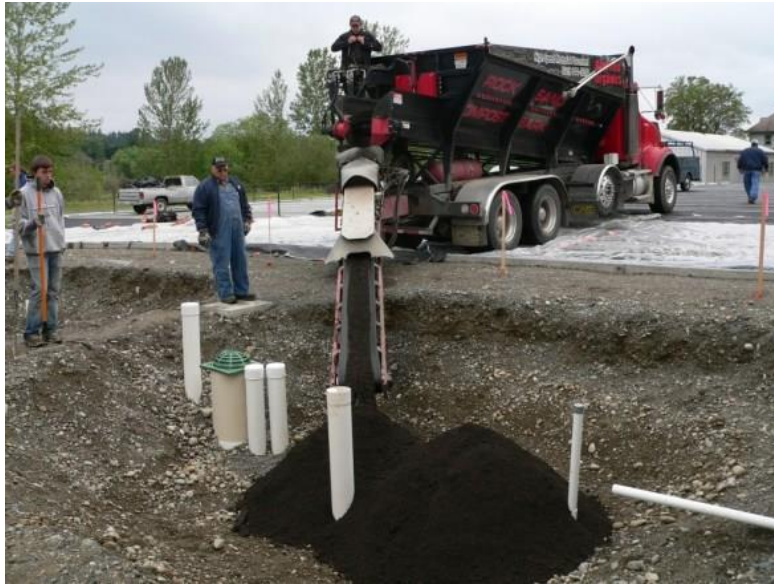
53. Irudia. Lur-nahastearen betelana. Iturria: Washington Stormwater Center
