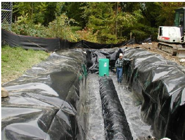
51. Irudia. Geotextilaren kokapena. Iturria: University of Maryland
