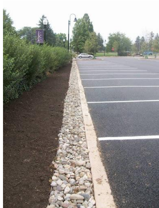
15. Irudia. Infiltrazio-zanga Lancaster-ren, Erresuma Batua. Iturria: cityoflancasterpa.com
