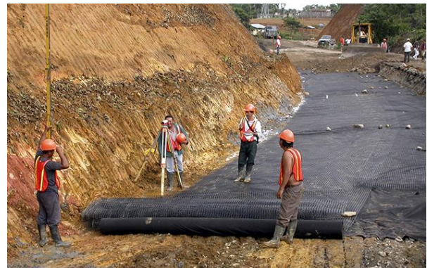
56. Irudia. Geotextilaren kokapena. Iturria: rafiaindustrial.com
