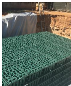
25. Irudia. Sare-formako biltegiak Bétera-n, Espainia. Iturria: Green Blue Management.
