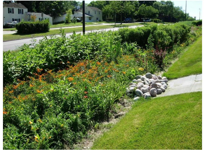
12. Irudia. Bio-erretentzio sistema Raleigh-en, Amerikako Estatu Batuak. Iturria: deeprooot.com
