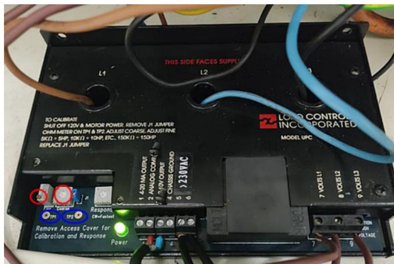
Ilustración 41. Medidor de potencia
