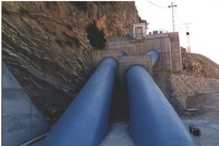
Imagen 14. Tubería de conducción de central hidroeléctrica. [22]
