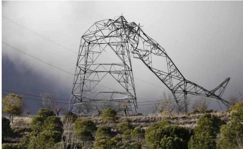
Imagen 34. Torre de alta tensión derribada debido a las inclemencias meteorológicas. [58]
