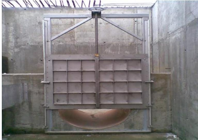
Imagen 13. Toma de agua y compuerta de una central. [19]
