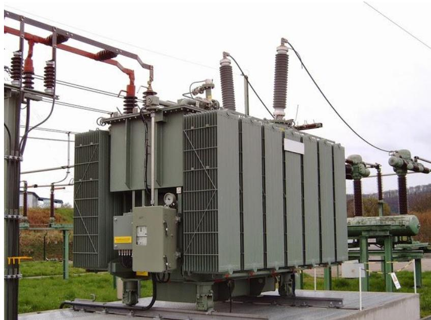
Imagen 26. Transformador eléctrico de alta potencia. [25]
