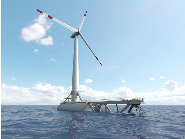
*Figura 22. Representación gráfica del prototipo DemoSATH [39].*
