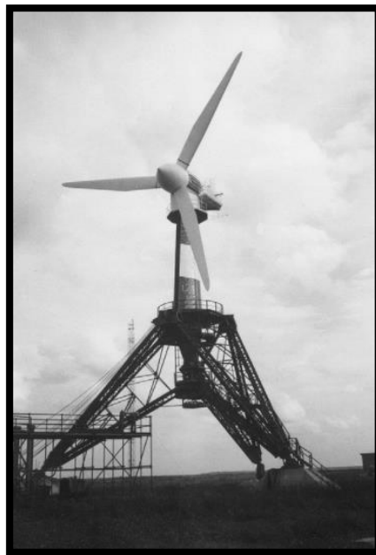
Figura 18. Aerogenerador Best Romani. 15
