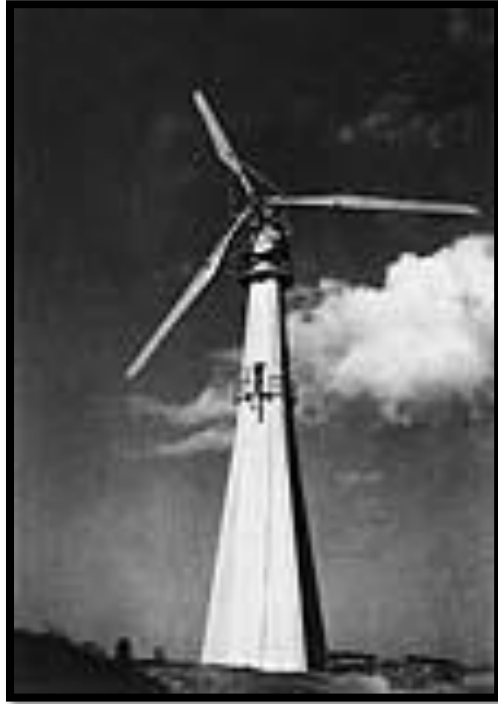
Figura 19. Aerogenerador tripala, 200 kW y 24 m de rotor. 16
