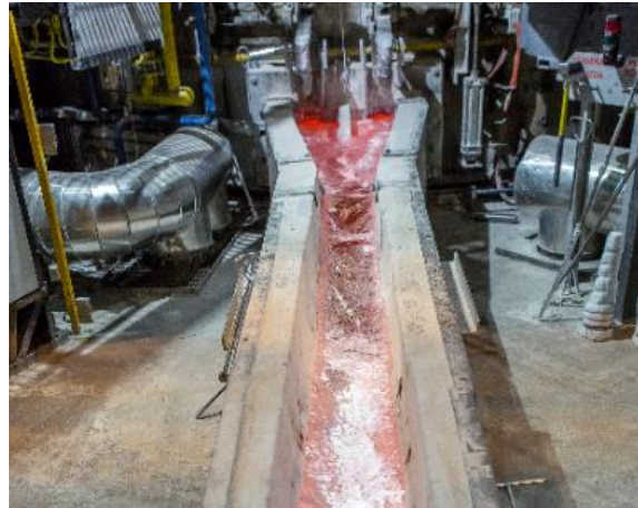
Ilustración 29: Canalizaciones para transportar el aluminio fundido
