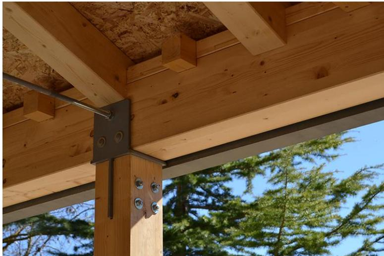
Figura 6.16. Ejemplos de uniones de pilar con tirante. Fuente: Madera y construcción
