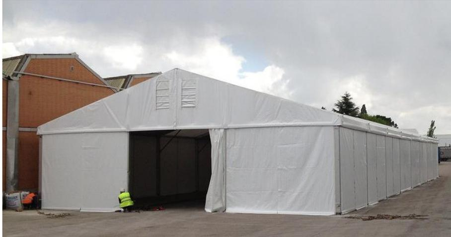
Figura 3.1. Ejemplo de sistema industrializado de aluminio y PVC. Fuente: Röder
