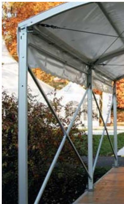
Figura 3.2. Pórtico de aluminio reforzados con cruces de San Andrés. Fuente: Röder
