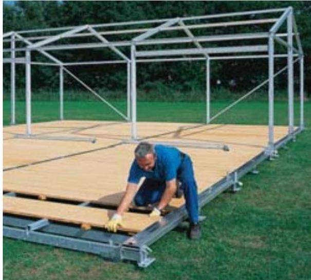
Figura 3.5. Instalación de suelo en un sistema de aluminio y PVC. Fuente: Röder
