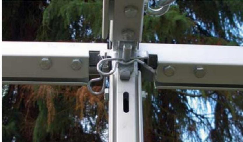
Figura 3.3. Unión viga – pilar de pórtico con viga perimetral. Fuente: Röder
