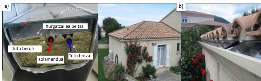
28. irudia. (a) Eguzki-modulu termikoaren egitura, (b) eguzki-kanala H2SS® [36].
