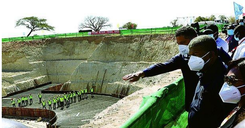
Presidente de Angola, Joao Lourenco, visitando la obra de construcción de la presa de Ndue, al sur del país.
