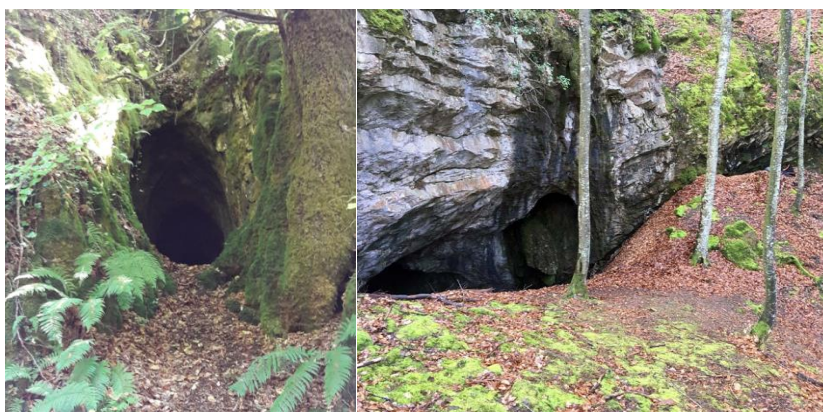
Fig.3.38. Característica sección ovoide en Otaño II, de una mina antigua y mina Aierdi IV
