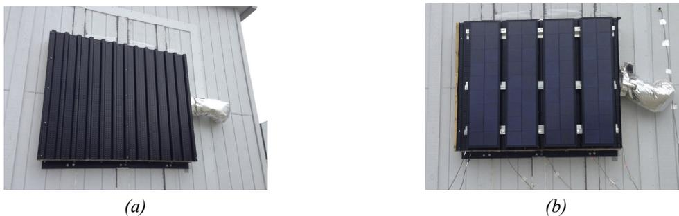
Figura 1.9. – Aspecto de un módulo del tipo (a) “unglazed transpired solar collector (UTC)” y (b) UTC con módulos fotovoltaicos, usados en la experimentación de [80].
