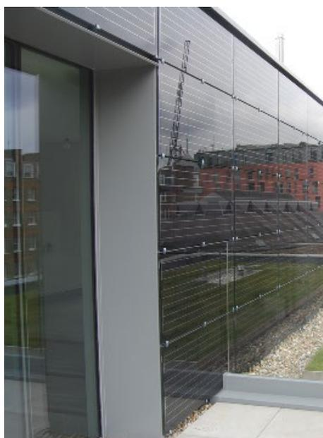
**Figura 5.1** –Fachada Ventilada Fotovoltaica Opaca en un edificio en planta ático de edificio terciario.
