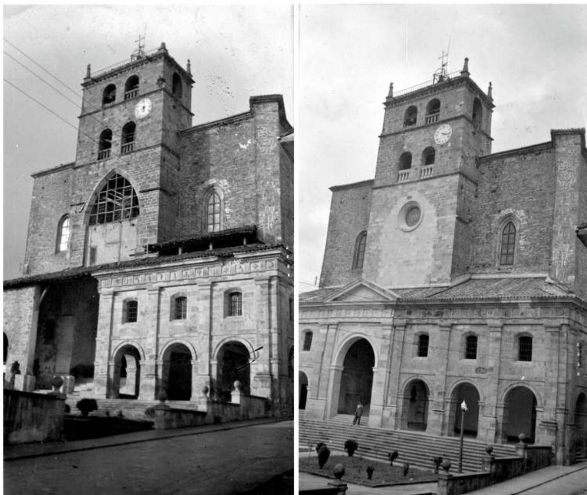
Fig. 141: Fachada principal de la iglesia parroquial de Elgeta en 1950 y en 1954 (fuente: Fondo Ojanguren, AGG-GAO).
