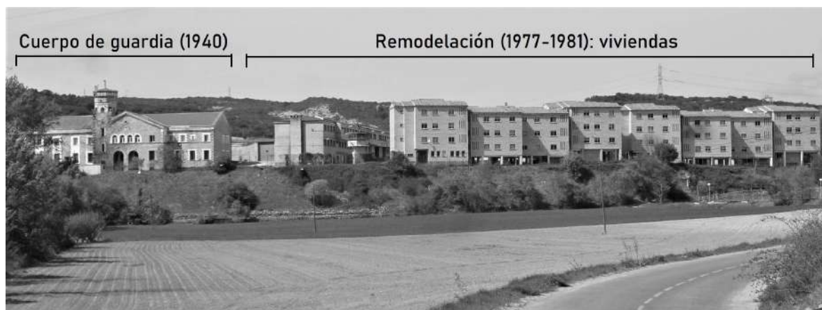
Fig. 129: El centro penitenciario de Nanclares en la actualidad. Yuxtaposición de viviendas de la remodelación y del cuerpo de guardia original.
