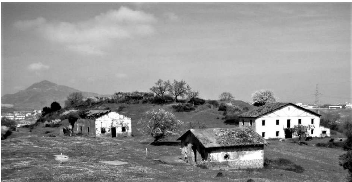
Fig. 131: La batería antiaérea de Durañona. En primer término, edificios de intendencia y alojamiento enmascarados como estructuras propias de la arquitectura rural vasca.
