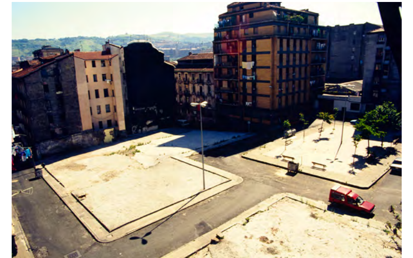
Plaza de la Cantera en el barrio de San Francisco a principios de los años 90 del siglo XX con varios solares tras el derribo de 3 edificaciones
