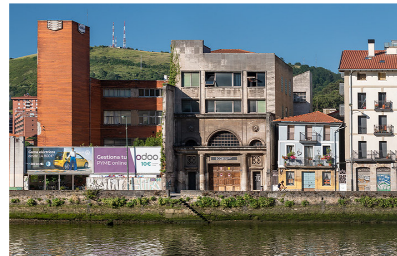
Vista del antiguo complejo industrial de Artiach
