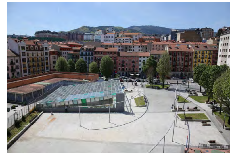
Cubierta y acceso sobre el claustro de las ruinas que se encuentra sobre la plaza Corazón de María
