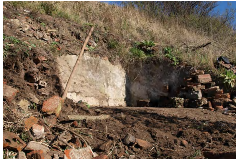
3. Se descubre por completo el diedro que conforman dos paredes en esquina y un suelo de cemento.
