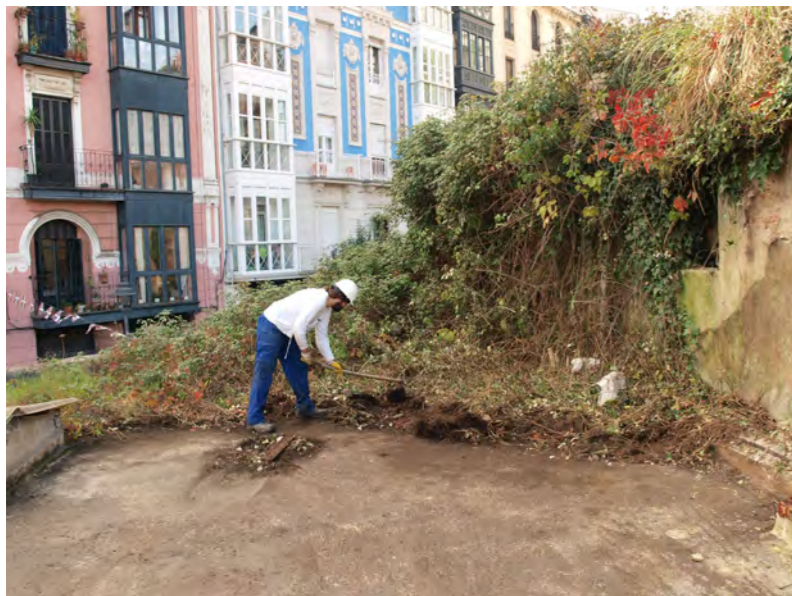
Limpieza de la cubierta del estudio-taller
