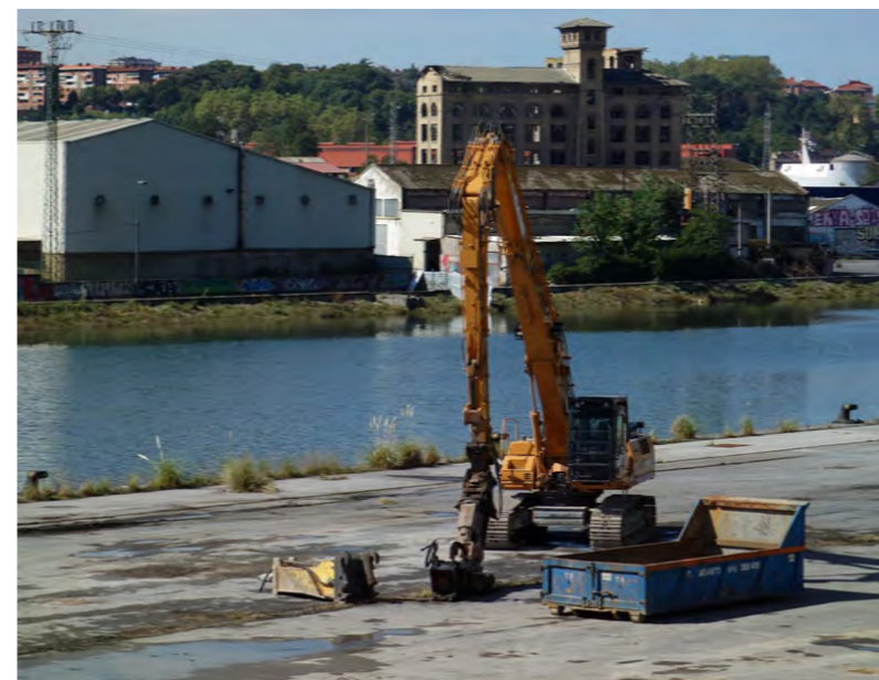
Maquinaria de derribo junto al edificio IDOM en 2017
