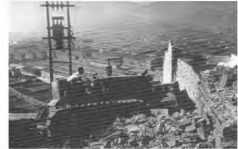
Derribo de viviendas autoconstruidas en el monte Cabras en los años 60 bajo el régimen fascista de Franco, en segundo plano de la foto el barrio de San Ignacia. Foto del libro Urbanismo y Vivienda en Bilbao. Veinte años de posguerra. Santa Torres, Aitor. Colegio Oficial de Arquitectos Vasco-Navarro Pamplona 2007.
