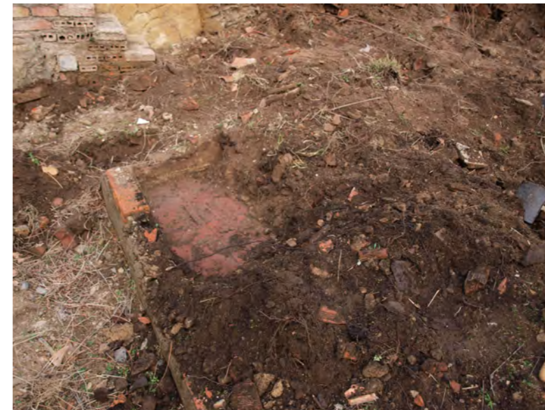
5. Se descubre cerca del final de la escalera los cimientos de una construcción junto a un suelo de baldosa hidráulica. En ese momento se detuvo y concluyó la excavación.
