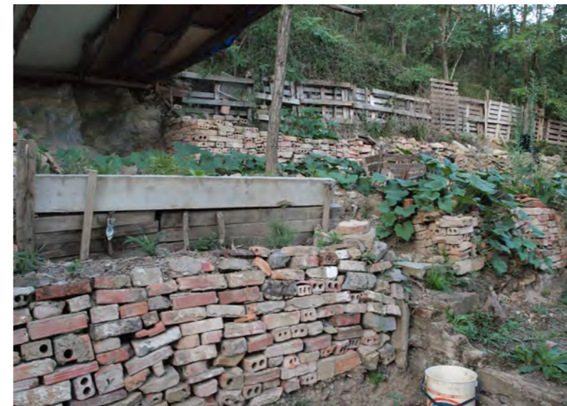
Detalle de la huerta y el sistema de terrazas que se implementó en su construcción utilizando el material desenterrado
