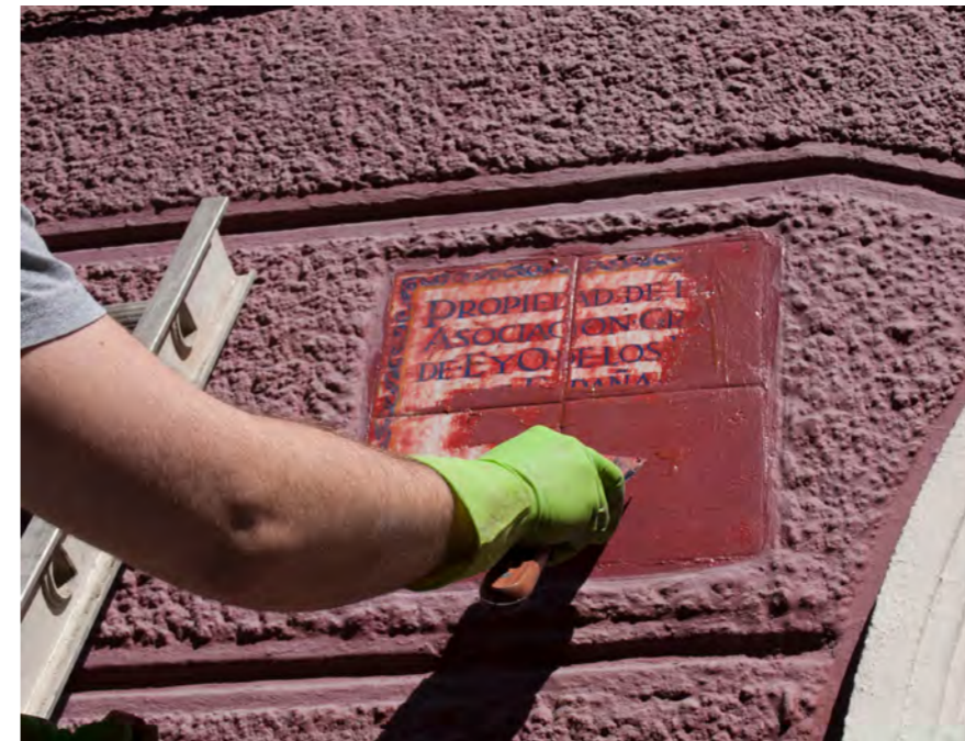
Restauración de una de las placas retirando la pintura que la tapaba
