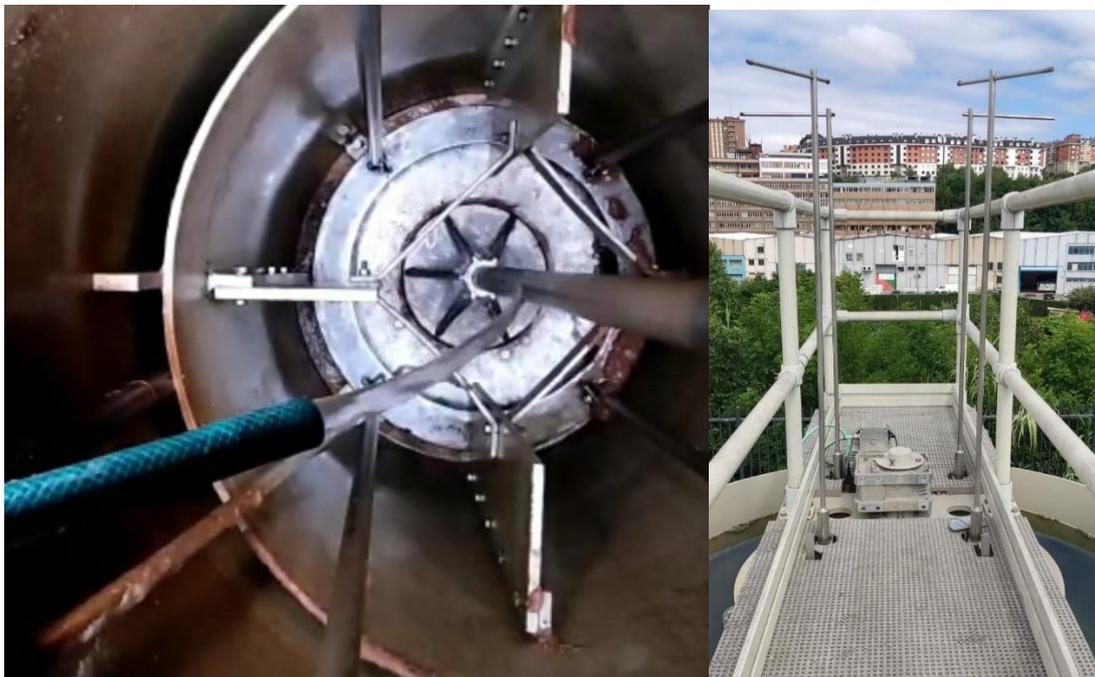
*Ilustración 29: (izq.) interior del decantador vacío, (dcha.) varillas de regulación del bandaje*
