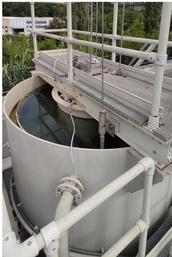
*Ilustración 11: Parte superior del decantador de la Planta piloto de Etxebarri en su funcionamiento ordinario*
