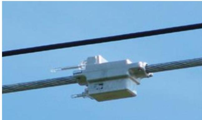
*Figura 2 Ejemplo sistema DLR de contacto.*
