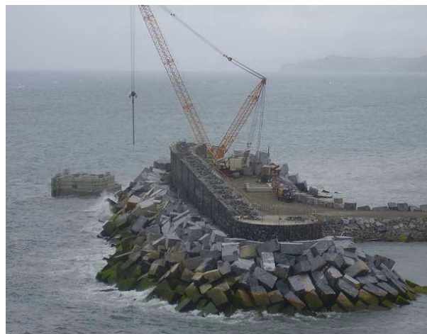
Figura 13. Construcción del dique de Mutriku [24]
