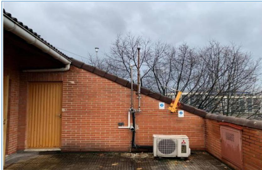
**Figura 33.** Detalle de los toma-muestras de la Estación Basauri
