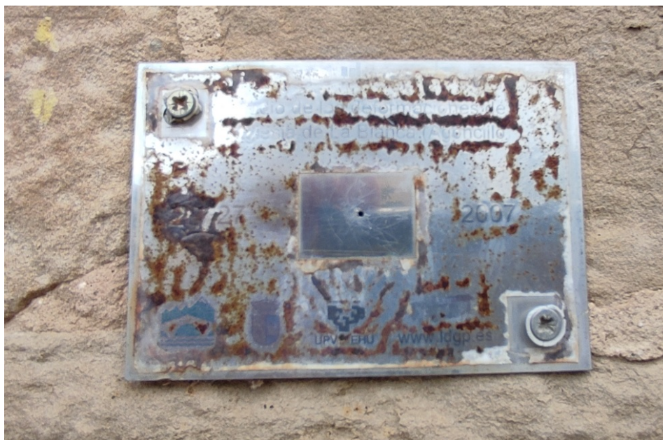
Figura 8. Estado de la placa con el punto D27 en julio de 2021. Se aprecia el desgaste de la rotulación, si bien el punto central —que define las coordenadas— sigue estando bien definido y pudo seguir utilizándose en la campaña de observación.
