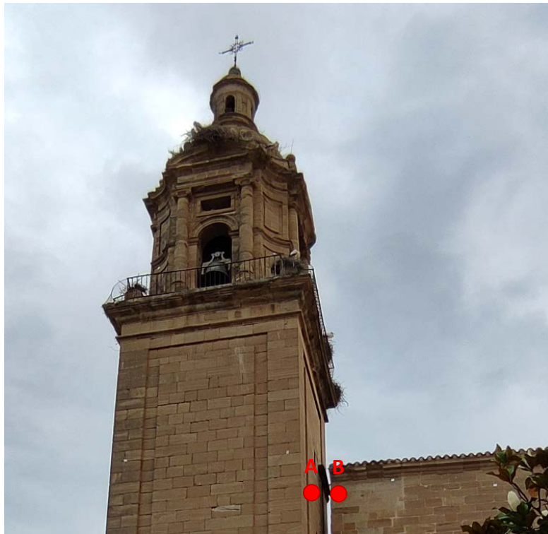
Figura 27. Propuesta de ubicación de las señales para el control periódico de la distancia entre la torre y el cuerpo de la iglesia.
