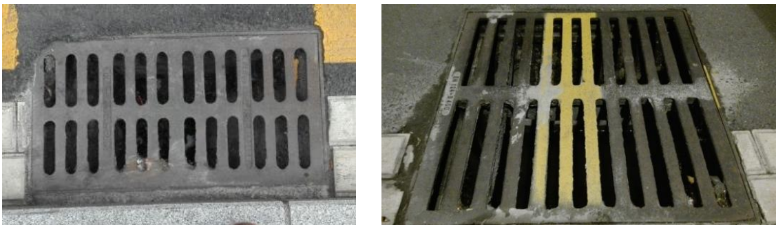
Figura 3.34 Dispositivo de cubrimiento clase C250 (izquierda) y de clase D400 (derecha).
