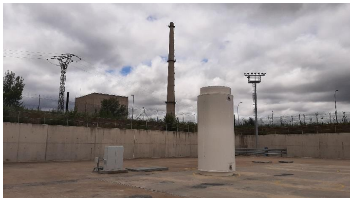
Ilustración 3: Primer contenedor almacenado en el ATI de la central de Garoña
