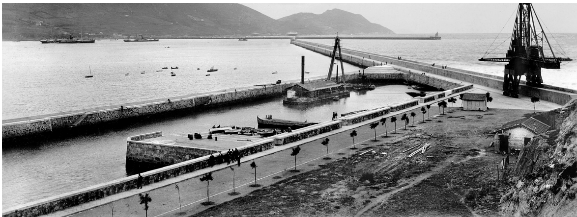
[Fig.12] Construcción del Muelle de Arriluze. (Archivo de la Autoridad Portuaria de Bilbao, signaturas 0596 y 3662) [Consulta: mayo de 2017]
