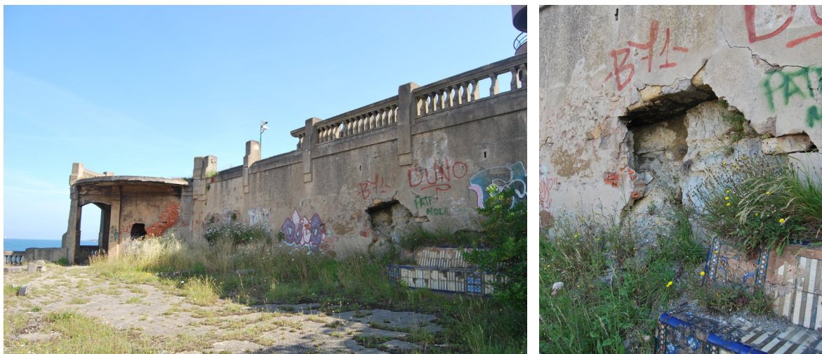
[Fig.19] Restos de aparejo mampuesto (Fotografías de elaboración propia, agosto de 2019).
