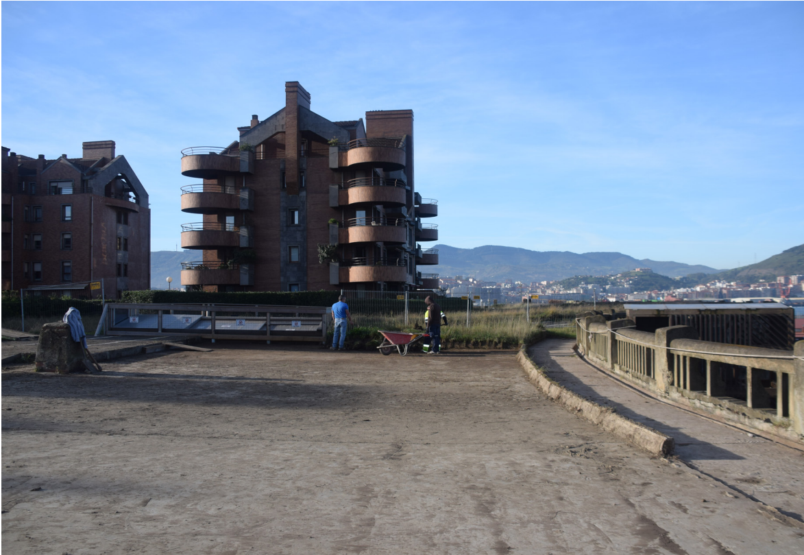
[Fig.24] Mortero de pendiente previo a su eliminación (Fotografía de elaboración propia, octubre de 2017).
