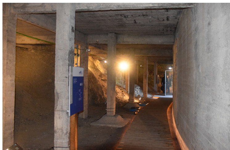
[Fig.15] Descoordinación de los pilares de la carpintería frente a la estructura (Fotografía de elaboración propia, agosto de 2017).
