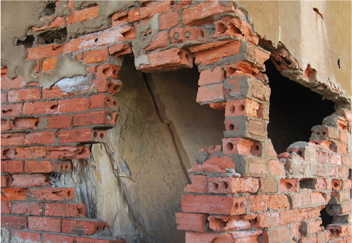
[Fig.34] Aparejo de la fábrica de ladrillo (Fotografía de elaboración propia, agosto de 2015).
