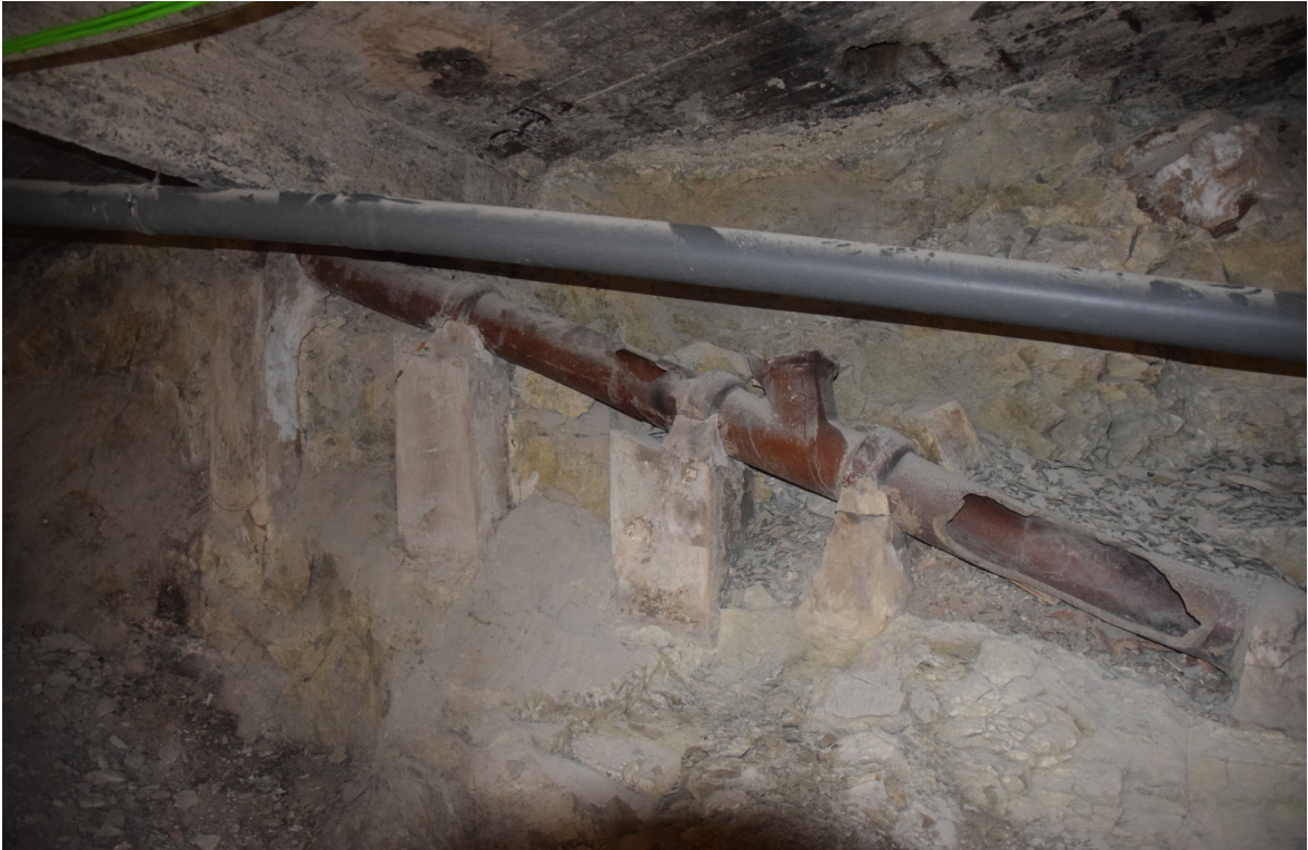
[Fig.30] Colector original y posterior (Fotografía de elaboración propia, agosto de 2017).
