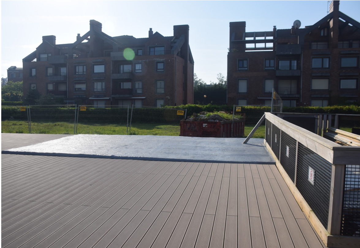
[Fig.85] Porción de forjado de mayor grosor en terraza sobre el salón (Fotografía de elaboración propia, mayo de 2018).
