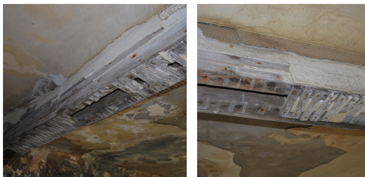
[Fig.56] Falsos techos de escayola (Fotografía de elaboración propia, julio de 2015).
