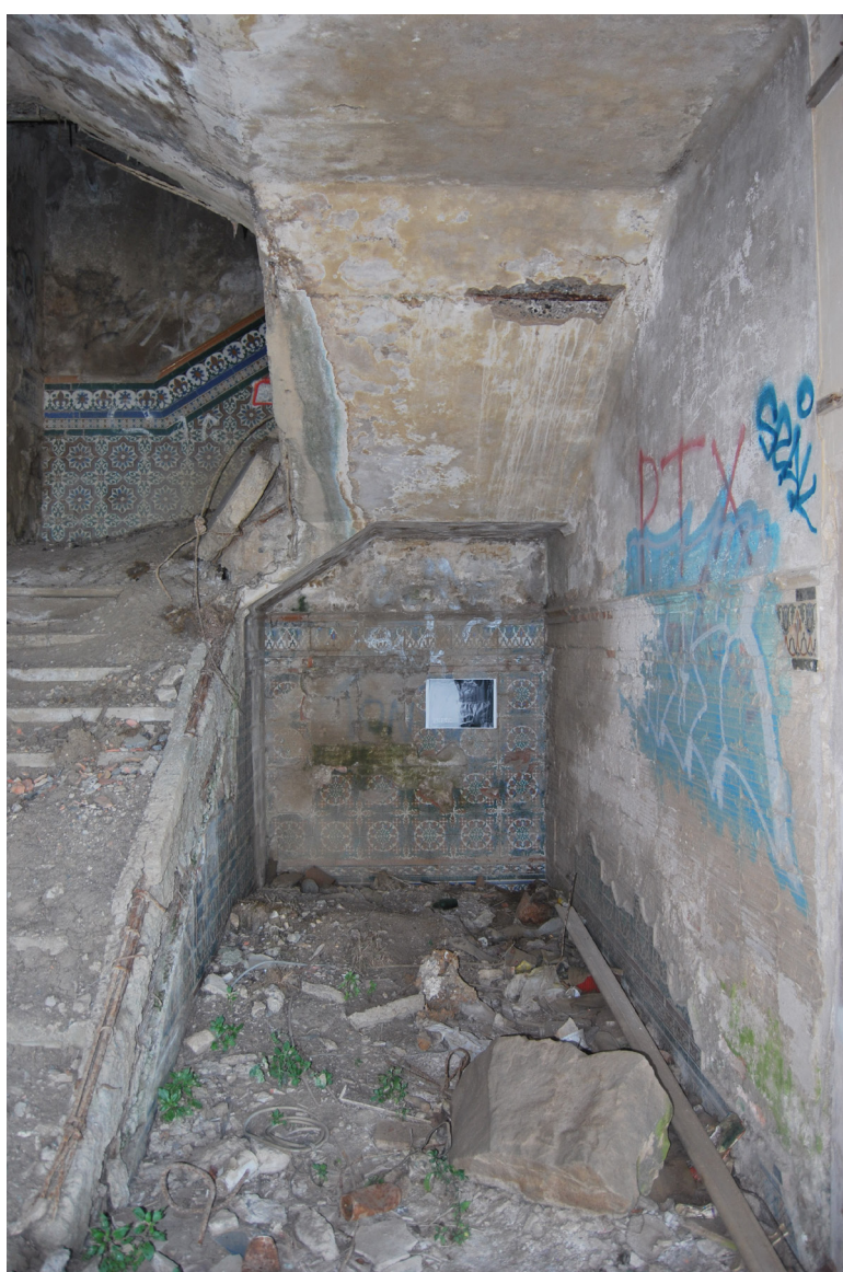
[Fig.17] Estado actual del espacio bajo la escalera de acceso al salón (Fotografía de elaboración propia, agosto del año 2015).
