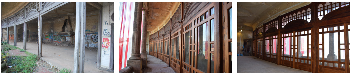
[Fig.4] Situación inicial en el año 2013 y progreso en la rehabilitación en el año 2019. (Fotografías de elaboración propia, septiembre de 2013 y mayo de 2019)
