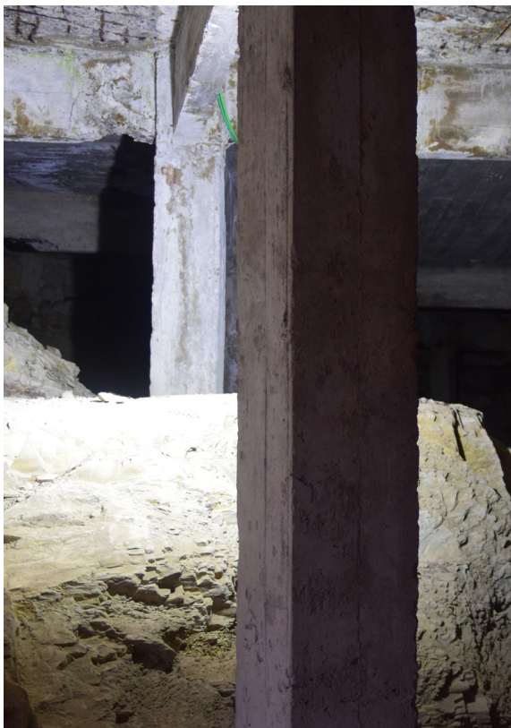
[Fig.9] Vigas, pilares y losas del tramo entre crujeas 9 a 30 (Fotografía de elaboración propia, julio de 2017).
