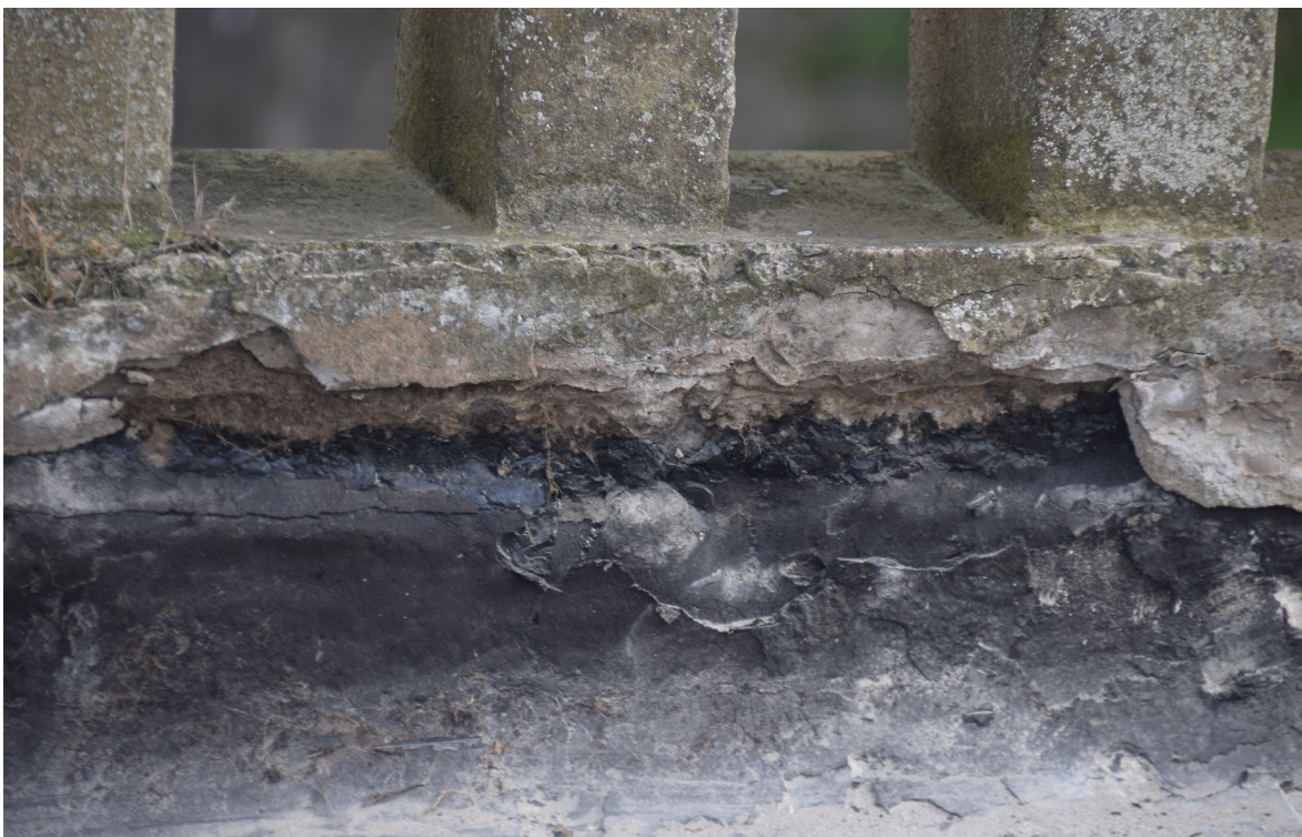
[Fig.23] Papel embreado e imprimación (Fotografía de elaboración propia, octubre de 2017).
