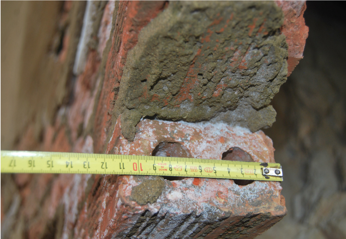
[Fig.36] Dimensión del Tizón del ladrillo (Fotografía de elaboración propia, agosto de 2015).
