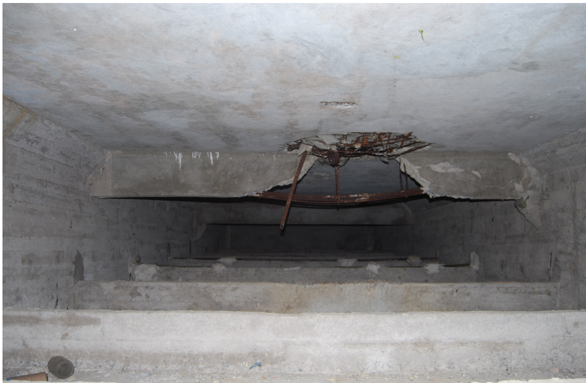
[Fig.32] Espacio entre forjados del salón para sujeción de lámparas (Fotografía de elaboración propia, noviembre de 2015).
