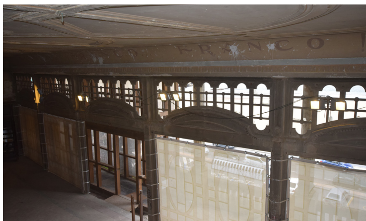
[Fig.55] Carpintería del salón (Fotografía de elaboración propia, julio de 2015).
