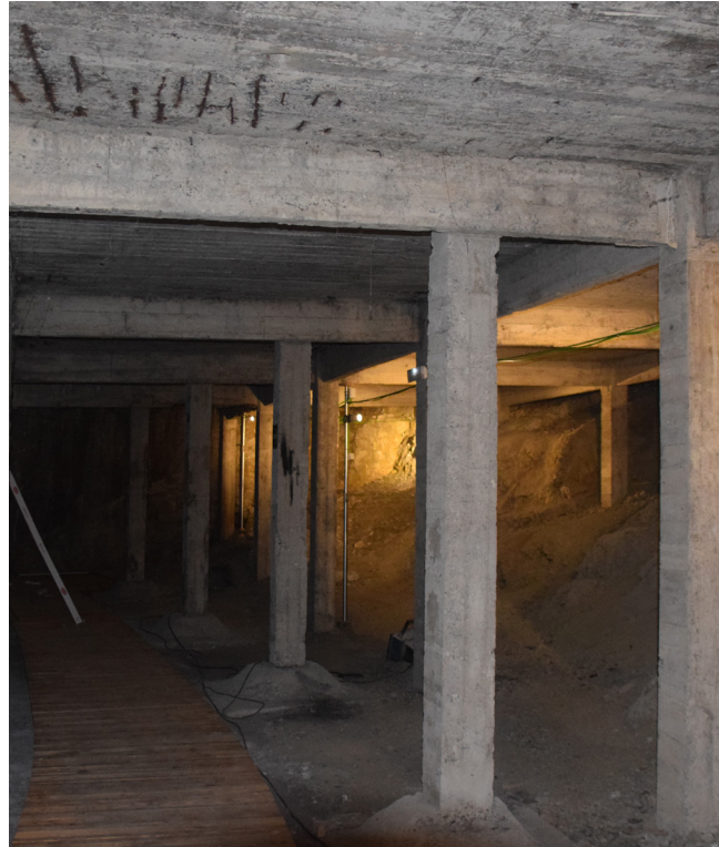
[Fig.8] Muro, vigas, pilares y losas del tramo entre crujeas 1 a 9 (Fotografía de elaboración propia, julio de 2017).
