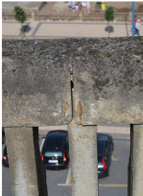
[Fig.74] Desaparición del mortero de unión entre piezas de la barandilla (Fotografía de elaboración propia, agosto de 2017).
