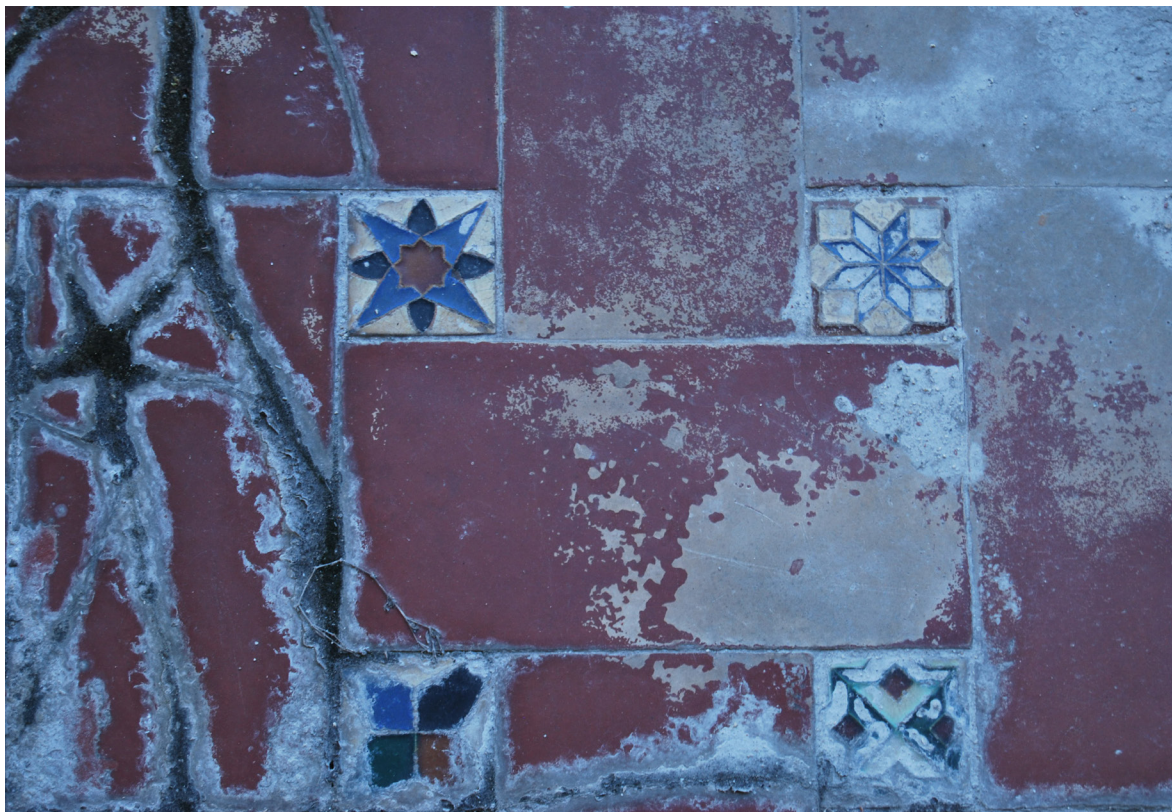
[Fig.43] Disposición de baldosines y olambrillas (Fotografía de elaboración propia, agosto de 2015).
