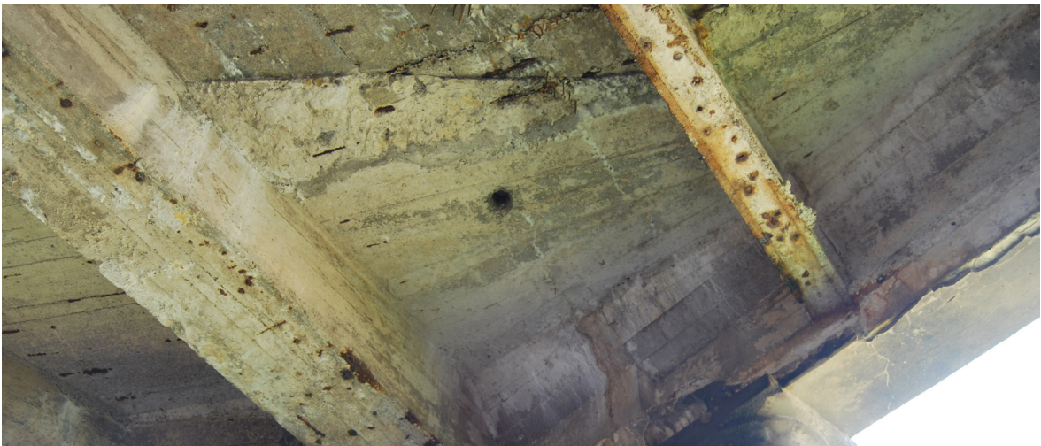
[Fig.58] Agujero de vertido (Fotografía de elaboración propia, enero de 2016)
