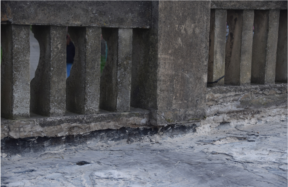
[Fig.26] Solape de lámina de impermeabilización en la estructura (Fotografía de elaboración propia, octubre de 2017).
