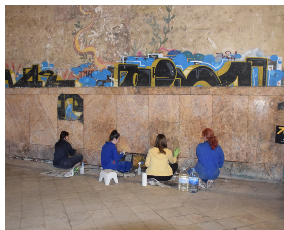
[Fig.66] Detalle de la pared suroeste del salón, con anterioridad al inicio de los trabajos de limpieza y consolidación de los paneles de piedra caliza roja y, labores de limpieza de los mismos (Fotografías de elaboración propia, enero de 2015 y junio de 2018).
