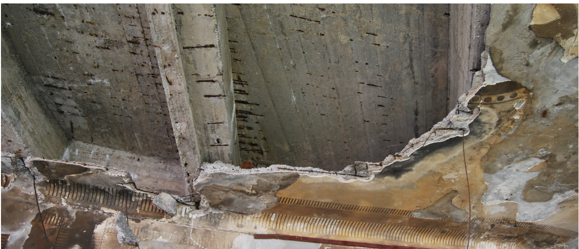
[Fig.59] Espesores de falso techo (Fotografía de elaboración propia, enero de 2015).
