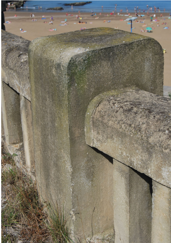
[Fig.73] Mortero de unión entre piezas de la barandilla (Fotografía de elaboración propia, agosto de 2017).
