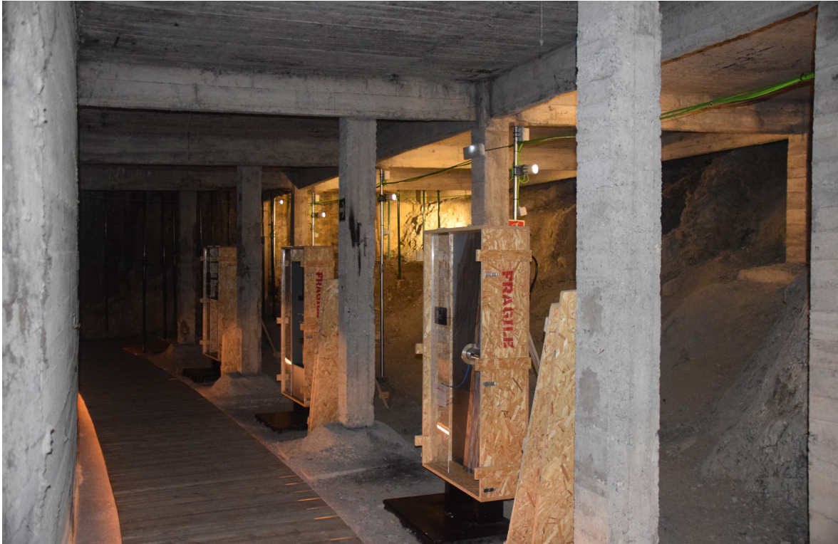
[Fig.1] Zapatas bajo el salón (Fotografía de elaboración propia, julio de 2017).
