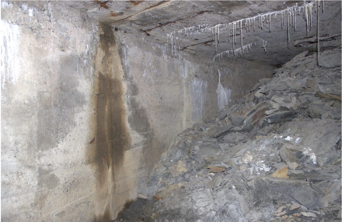
[Fig.11] Muro y losa del tramo entre crujeas 20A a 29 (Fotografía de elaboración propia, julio de 2017).
