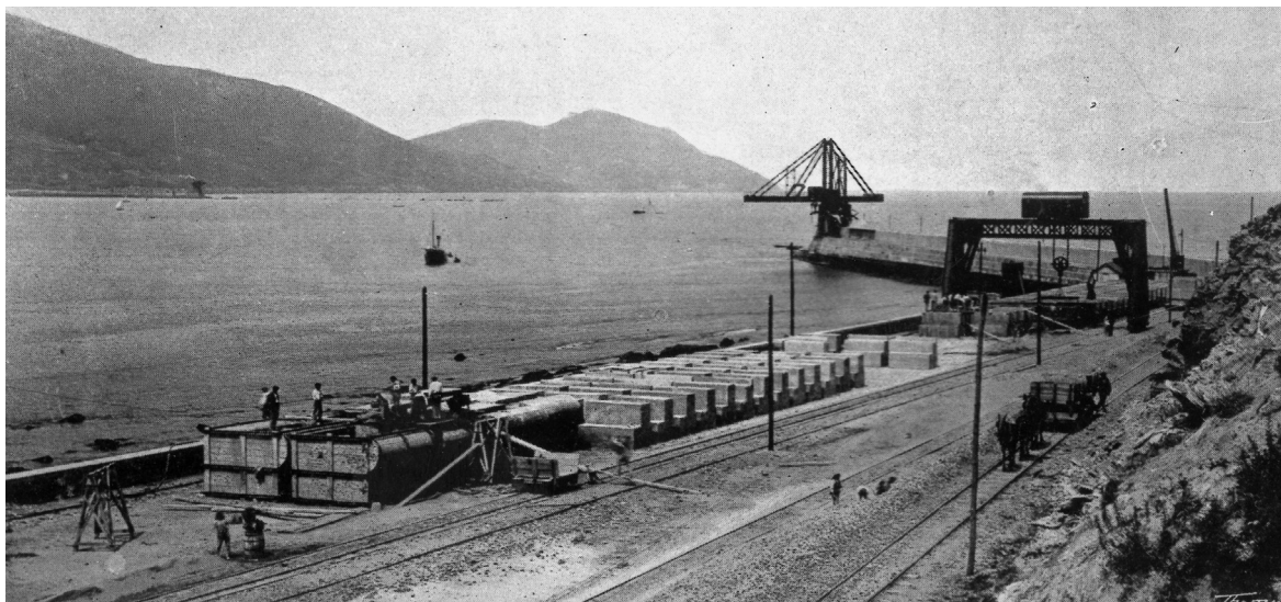
[Fig.11] Fotografía de las labores de construcción del dique de Arriluze. (Archivo de la Autoridad Portuaria de Bilbao, signatura 3662)[Consulta: mayo de 2017]
