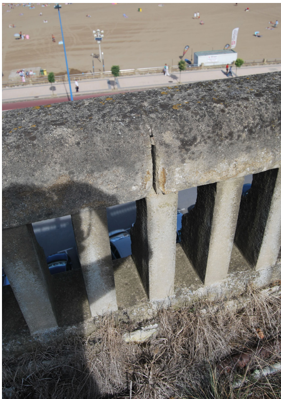
[Fig.74] Desaparición del mortero de unión entre piezas de la barandilla (Fotografía de elaboración propia, agosto de 2017).
