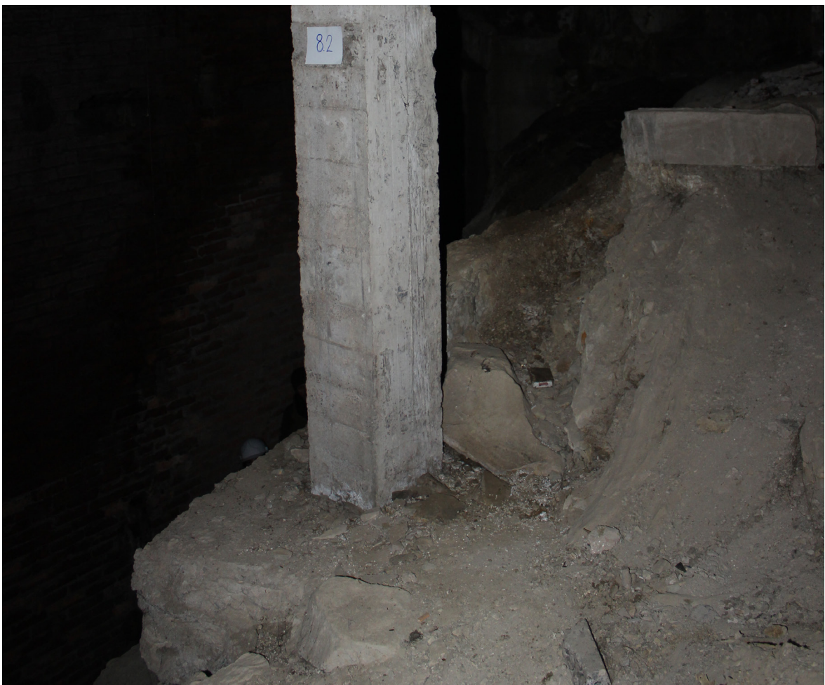
[Fig.2] Zapata bajo forjado (Fotografía de elaboración propia, agosto de 2016).
