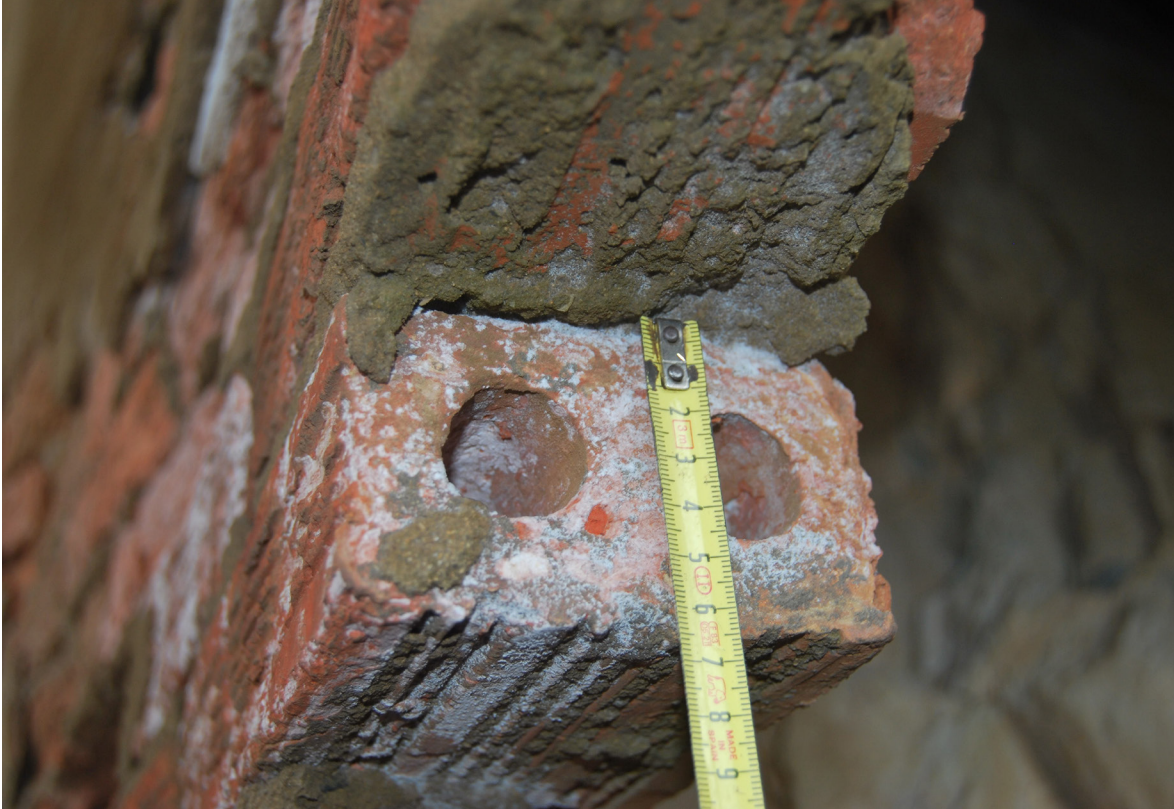
[Fig.37] Dimensión del Grueso del ladrillo (Fotografía de elaboración propia, agosto de 2015).
