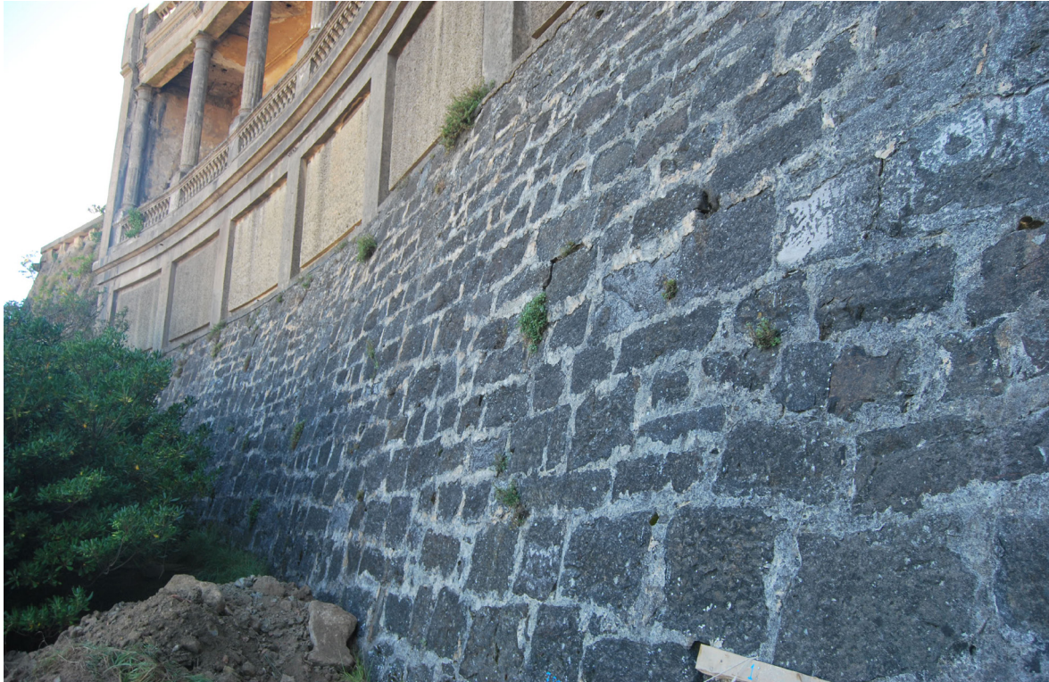
[Fig.3] Paño de muro bajo el salón en la galería noroeste (Fotografía de elaboración propia, septiembre de 2015)
