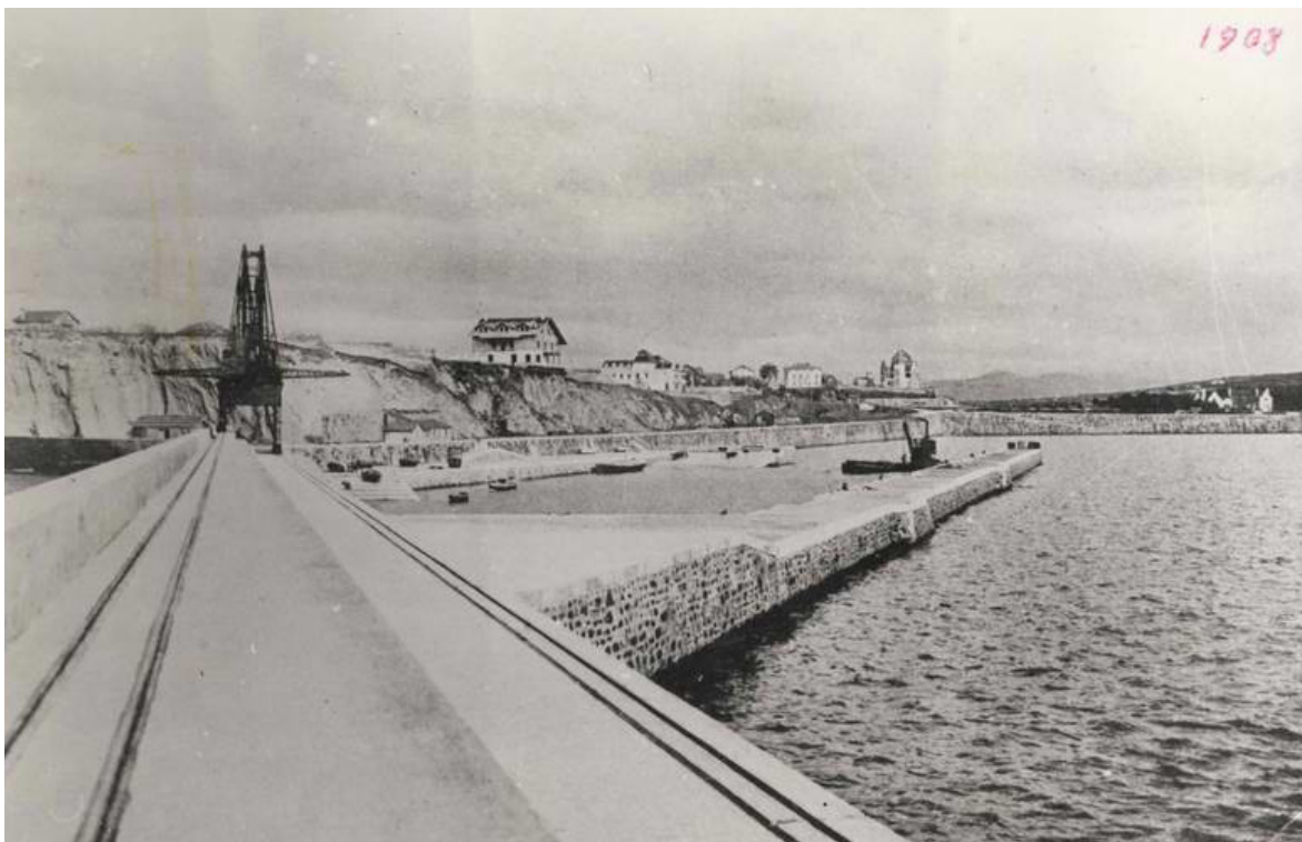
[Fig.14] Fotografías del acantilado previo a la construcción del muro y de las galerías (Archivo fotográfico del Ayuntamiento de Getxo) [Consulta: Junio de 2017]. Signatura Z00332
