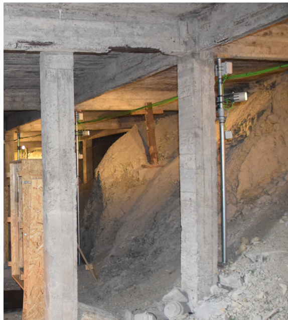
[Fig.18] Rollizo de apuntalamiento (Fotografía de elaboración propia, agosto de 2017).
