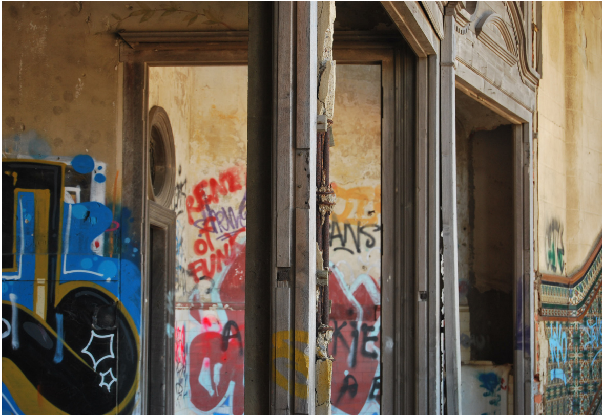
[Fig.79] Jambas de hormigón en puertas de madera (Fotografía de elaboración propia, junio de 2013).
