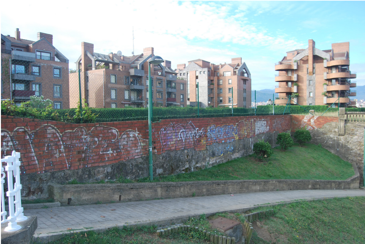
[Fig.9] Base conformada por los restos del muro original. (Fotografía de elaboración propia, agosto de 2014)
