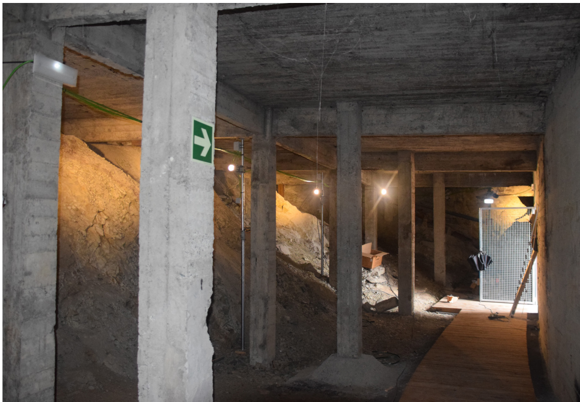
[Fig.69] Estructura secundaria (Fotografía de elaboración propia, julio de 2017).
