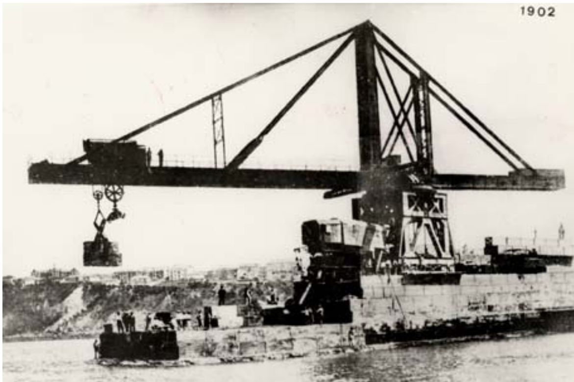
[Fig.13] Construcción del Muelle de Arriluze. (Archivo de la Autoridad Portuaria de Bilbao, signaturas 0596 y 3662) [Consulta: mayo de 2017]
