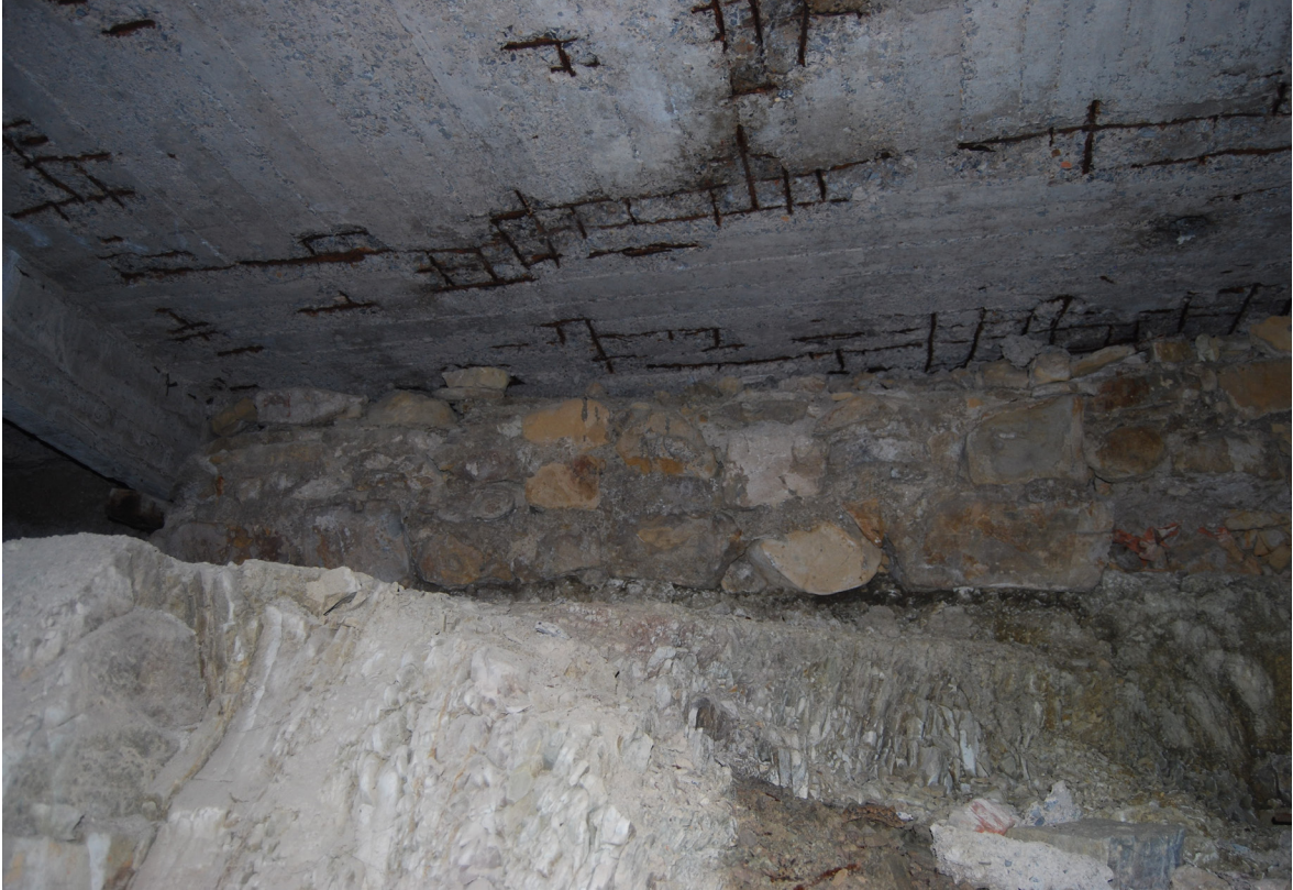
[Fig.83] Apoyo de losa sobre muro preexistente (Fotografía de elaboración propia, noviembre de 2016).
