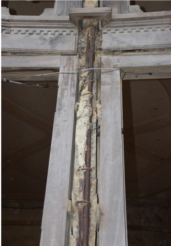
[Fig.16] Pilarillos de la carpintería (Fotografía de elaboración propia, diciembre de 2018).
