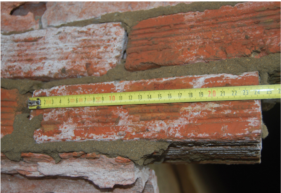
[Fig.35] Dimensión de la Soga del ladrillo (Fotografía de elaboración propia, agosto de 2015).
