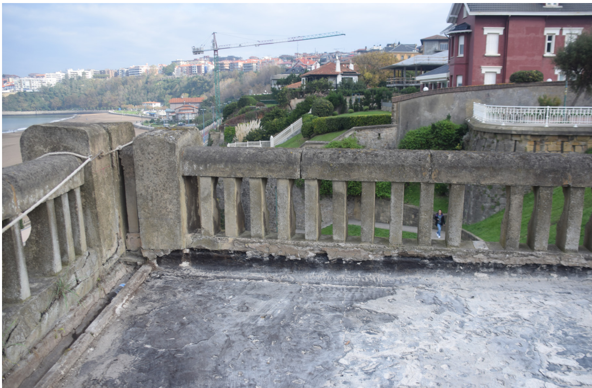
[Fig.28] Continuidad de la lámina de impermeabilización (Fotografía de elaboración propia, octubre de 2017).
