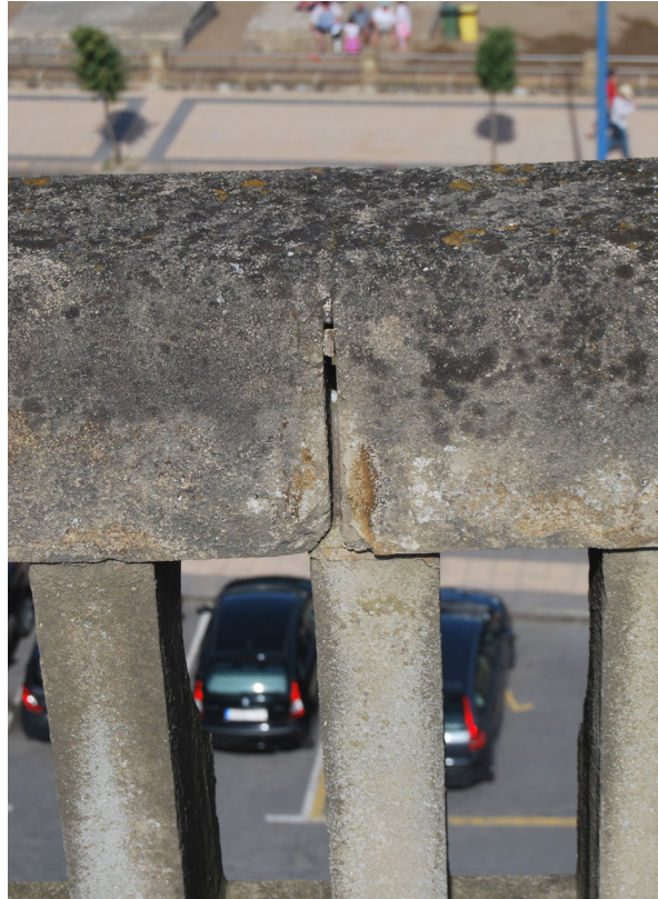
[Fig.73] Mortero de unión entre piezas de la barandilla (Fotografía de elaboración propia, agosto de 2017).
