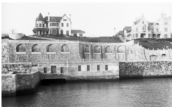
[Fig.6] Fotografía perteneciente al período previo a la construcción (Autoridad Portuaria de Bilbao)[ Consulta: mayo de 2017]. Signatura 0349.
