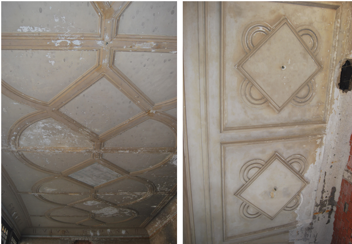
[Fig.60] Falsos techos de salón y vestíbulo previo (Fotografía de elaboración propia, enero de 2015).
