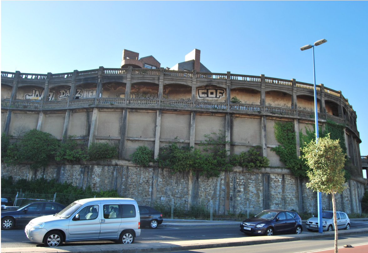
[Fig.5] Tramo adicional al salón de la galería noroeste (Fotografía de elaboración propia, septiembre de 2015).
