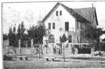
Un hotel en construcción de la manzana 73
