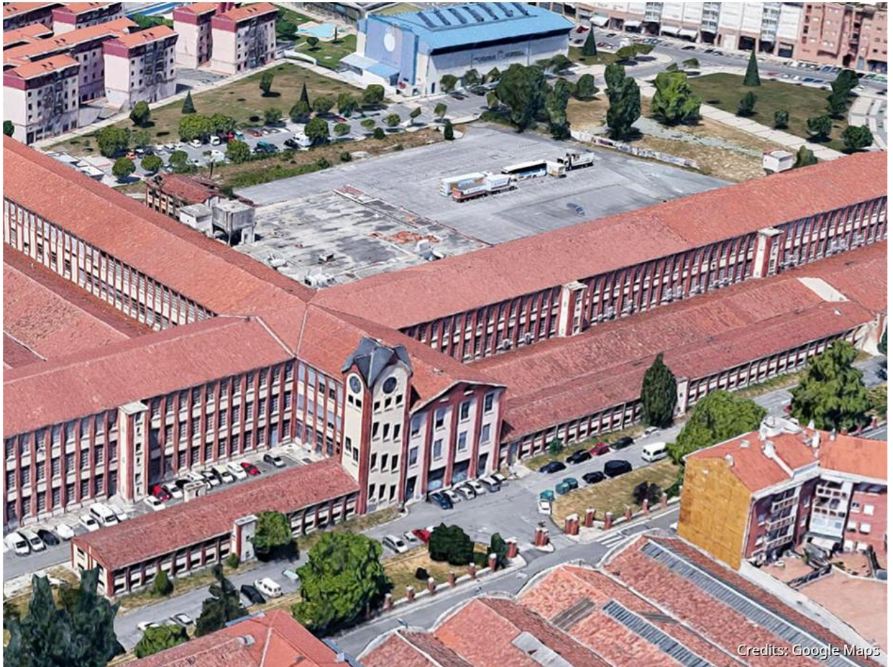
Figura 6: Parte de la fachada del edificio Iwer
