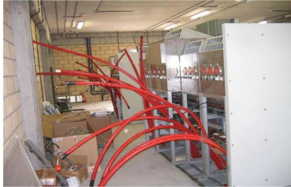
Figura 30. Montaje de Subestación de 24 kV en Leioa [59]
