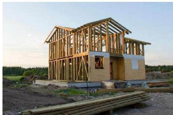
Ilustración 49: Construcción de Entramado Ligero
