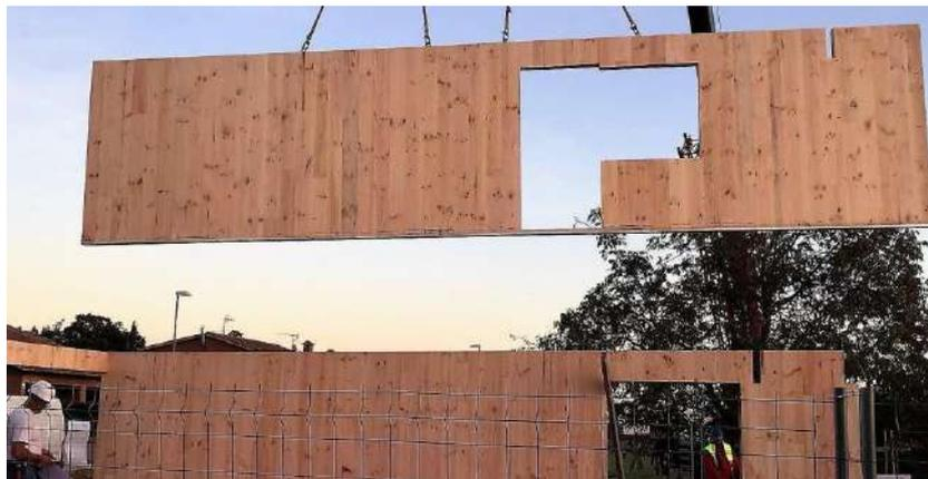
*Ilustración 66: Fachada de CLT*
