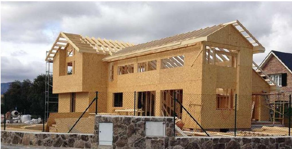
*Ilustración 40: Montaje de Entramado Ligero*
