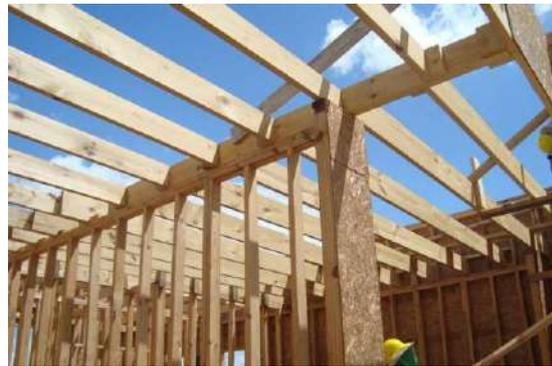
*Ilustración 47: Composición y estructura del Entramado Ligero*
