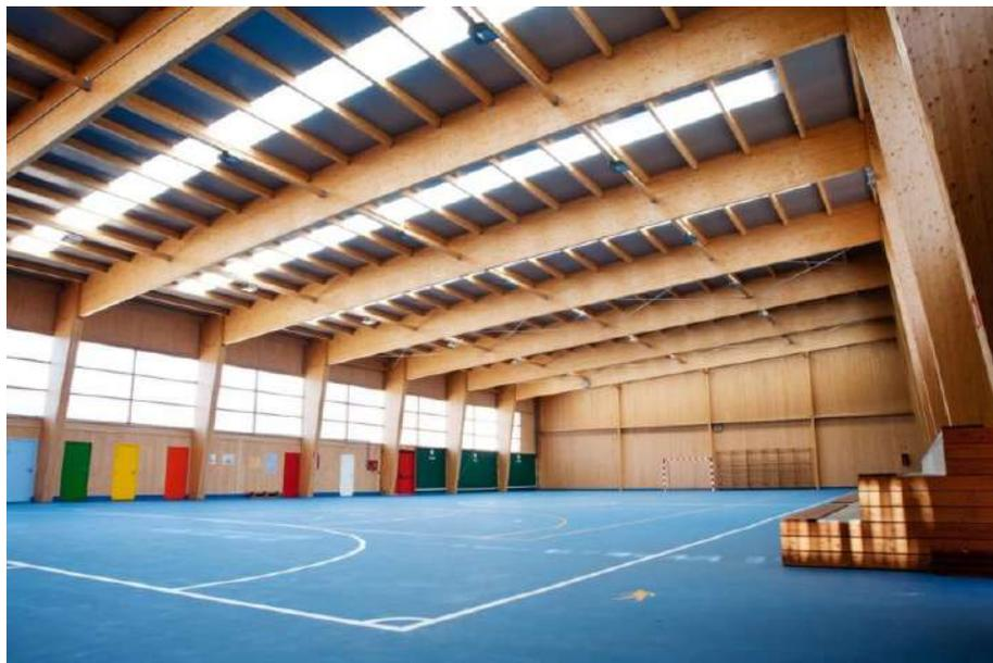
*Ilustración 29: Polideportivo con estructura de CLT*
