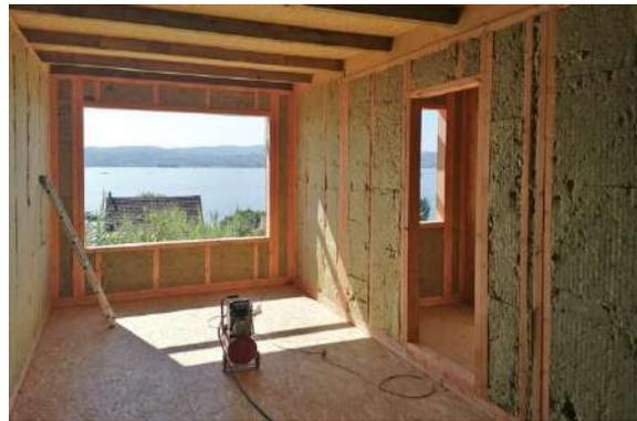
Ilustración 74: Aislamiento en fachada de Entramado Ligero
