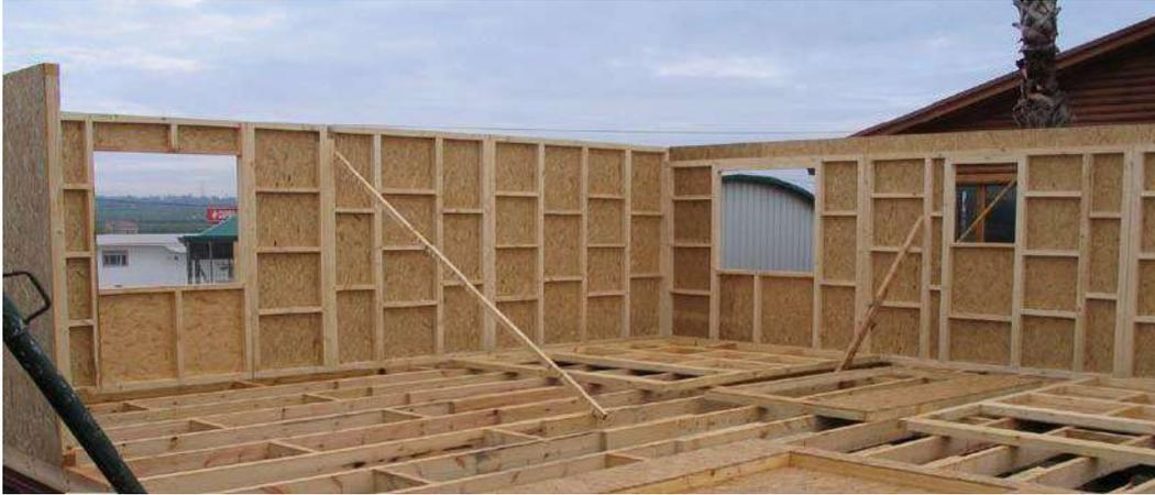
*Ilustración 39: Montaje de paredes de Entramado Ligero*
