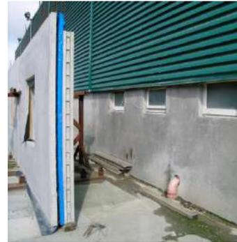
*Ilustración 9: Muro de panel sándwich*
