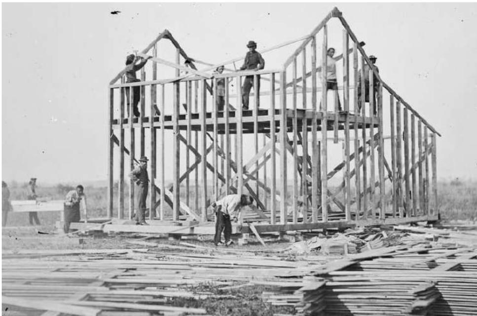
*Ilustración 31: Construcción de Entramado Ligero en la antigüedad*
