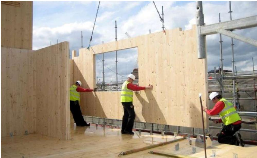
*Ilustración 23: Montaje de fachada CLT*
