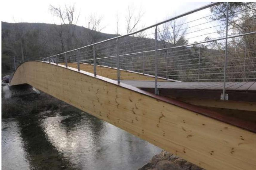
*Ilustración 30: Puente con CLT*
