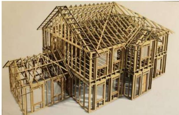
*Ilustración 34: Diseño de una vivienda de Entramado Ligero*
