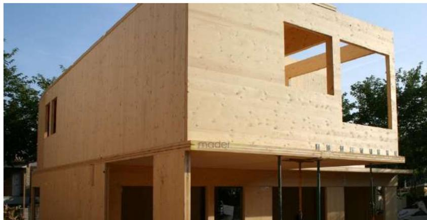
*Ilustración 67: Fachada de CLT*
