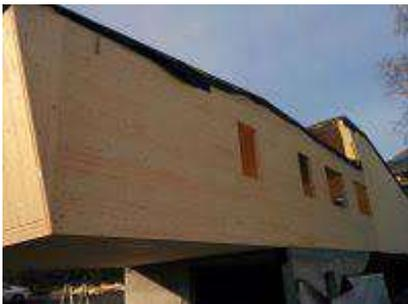
Ilustración 71: Fachada de CLT
