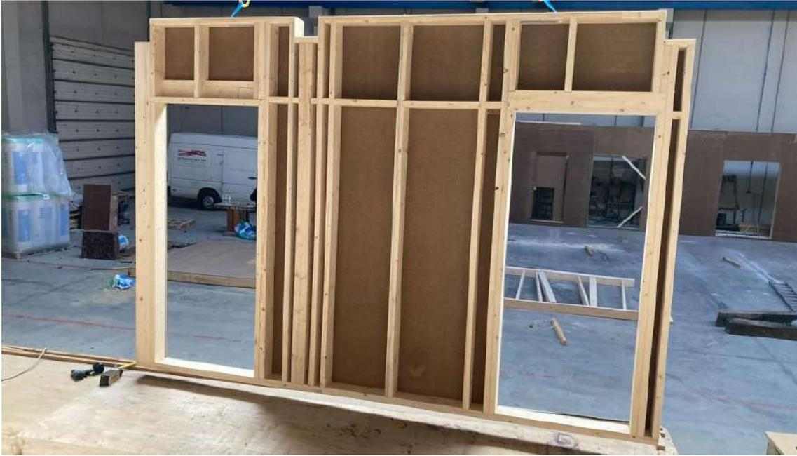
*Ilustración 38: Montaje y aberturas en una pared de Entramado Ligero*
