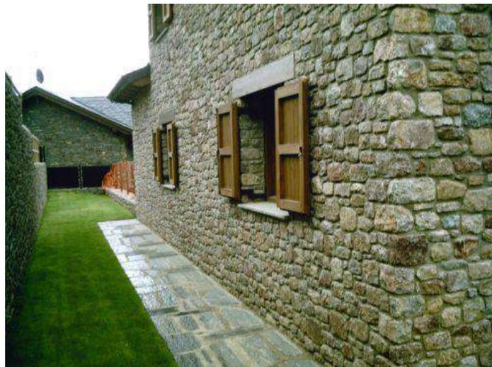
*Ilustración 5: Construcción con mampostería de piedra*
