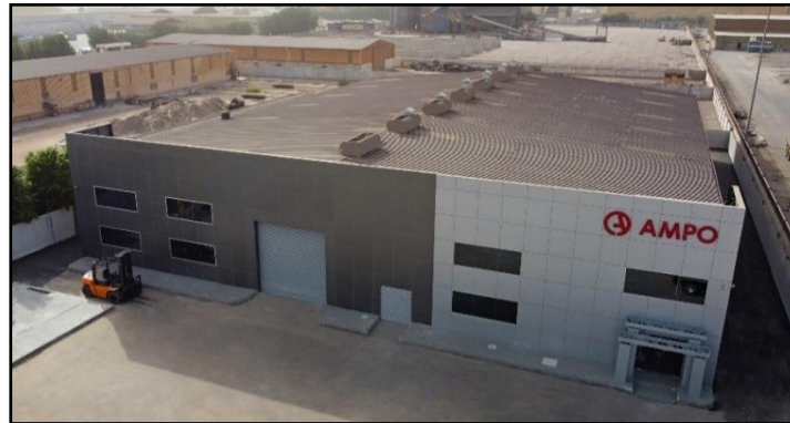
Figura 5. Instalaciones AMPO Arabia.
