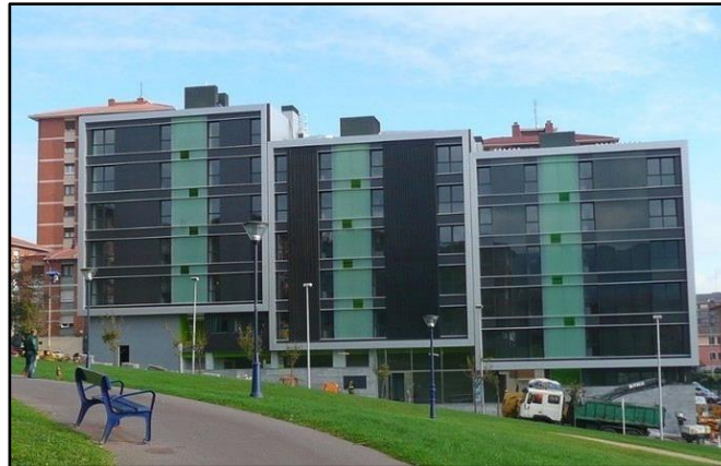
Figura 1. Edificio de la vivienda social efectiva de Portugalete [1].
