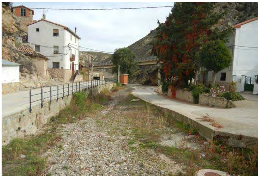
Figura 111. Conducciones y colectores que incrementan el estrechamiento del cauce del río Seco (Hoz de la Vieja, Teruel)
