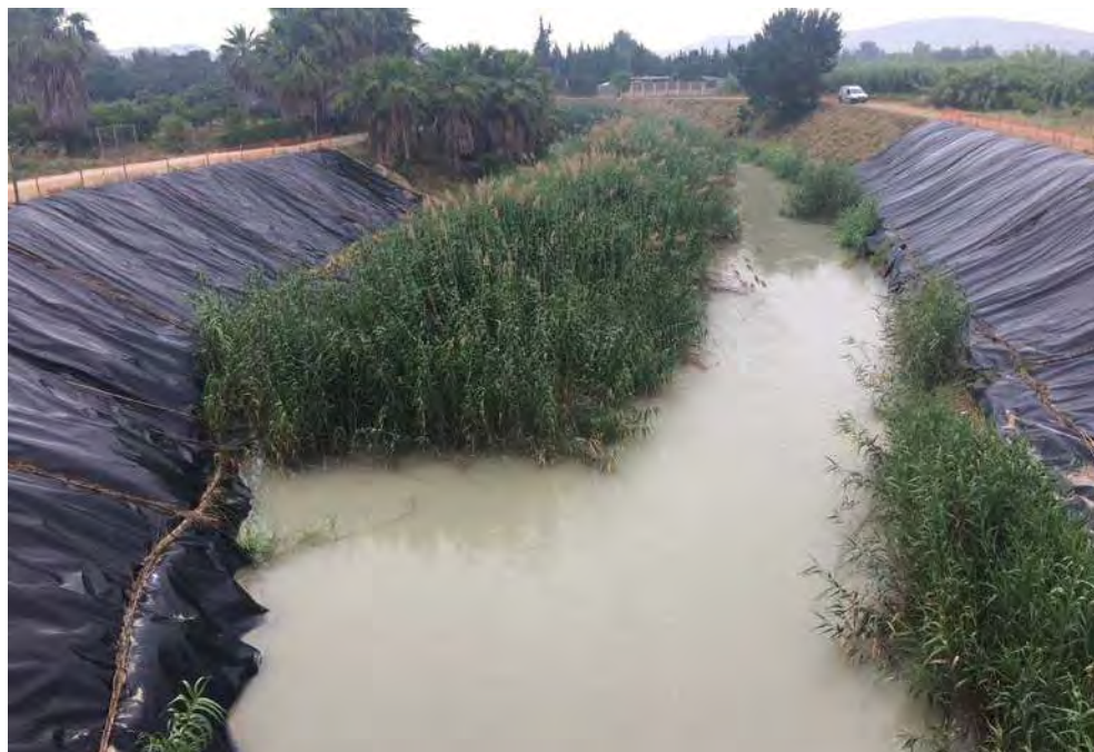
Figura 115. Ejemplo en un río permanente (río Segura en Molina de Segura, Murcia) del tratamiento para eliminación de cañas en ambas márgenes del cauce.
