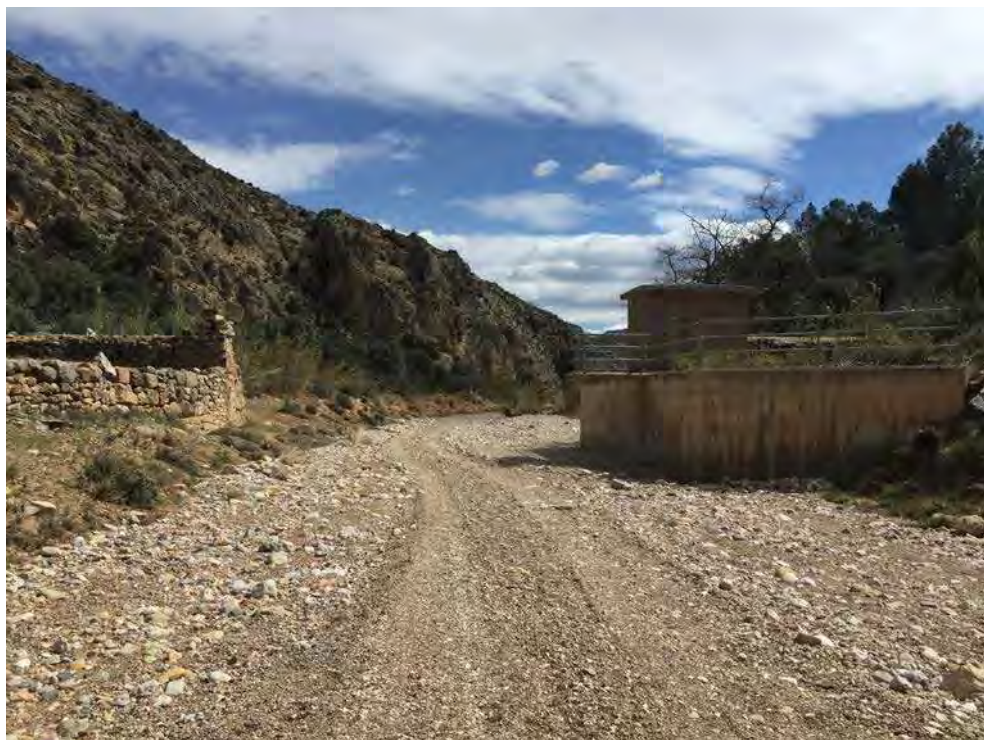
Figura 126. Una de las muy escasas estaciones de aforo en la red efímera de la cuenca del Ebro, la del río Seco en Oliete (Teruel), construida tras la avenida de 2013, que causó una víctima mortal.
