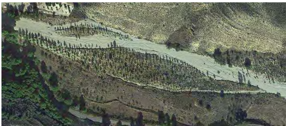
Figura 114. Plantaciones dentro del cauce del barranco de La Nava (Aguilar de Río Alhama, La Rioja).
