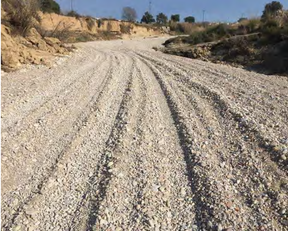
Figura 106. Cauce del río Foix (Cubelles, Barcelona)
