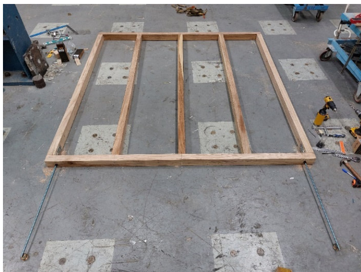
Figura 45. Estructura ensamblada previo a colocación de tableros
