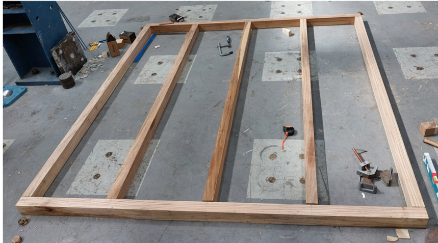
Figura 42. Estructura del muro
