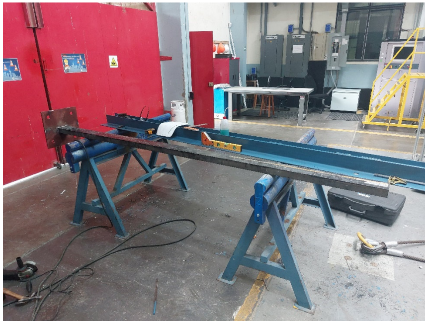
Figura 55. Preensamblaje viga de carga
