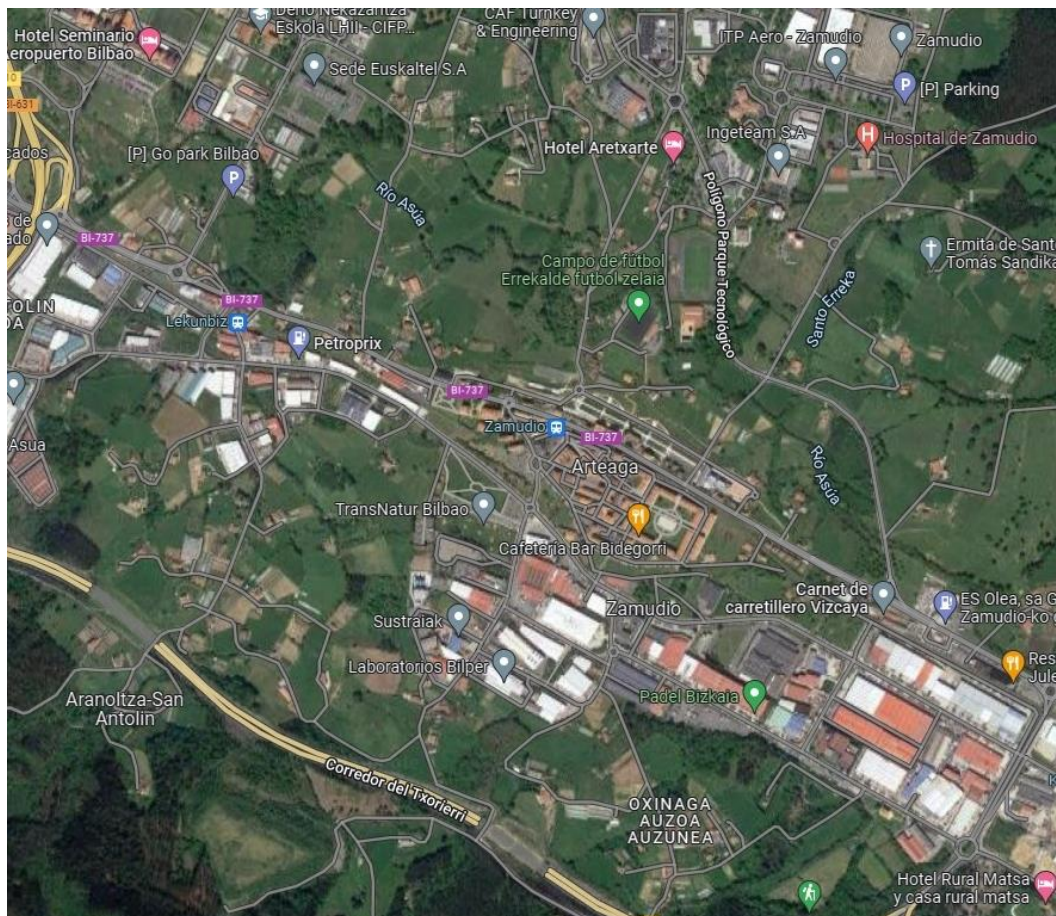
Figura 1. Vista aérea del parque industrial de Zamudio
