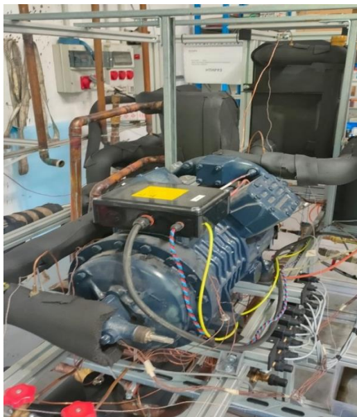
10. Irudia: Tecnaliak erabilitako HEEX1500CC konpresorea
