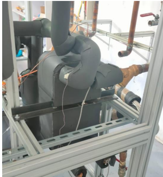
13. Irudia: Tecnaliak erabilitako SWEP V200Tx70/1P lurrungailua
