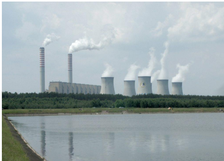
Figura 7-11. Central eléctrica de Belchatów.
